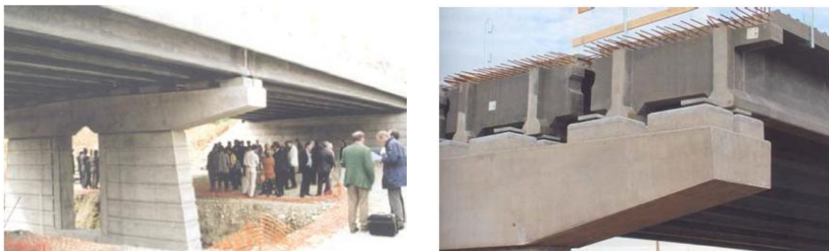
Rys. 3 i 4. Wiadukt Bourge-les-Valence we Francji podczas wznoszenia [4]
