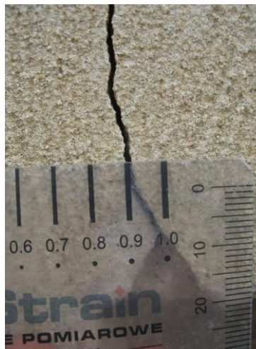
Rys. 3. Sposób dokonywania pomiarów rozwartości rys za pomocą wzornika
