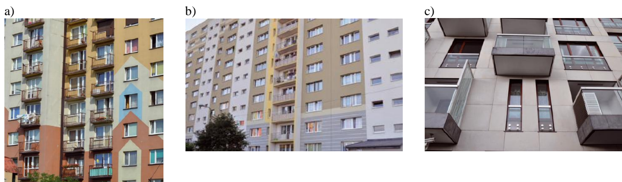
Rys. 5. Ewolucja elewacji budynków wielkopłytowych: a) faza I, b) faza II, c) faza III
