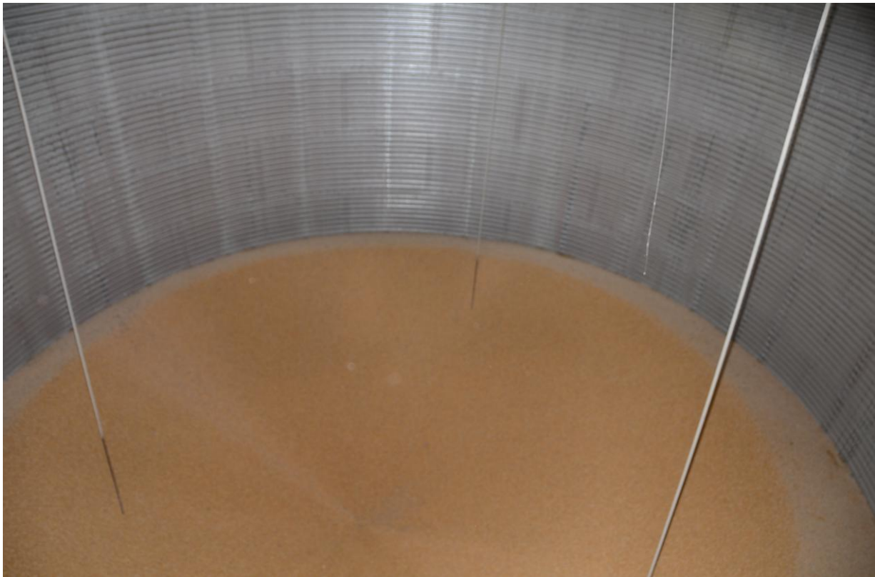
Rys. 2. Układ sond obwodowych w silosie na zboże
