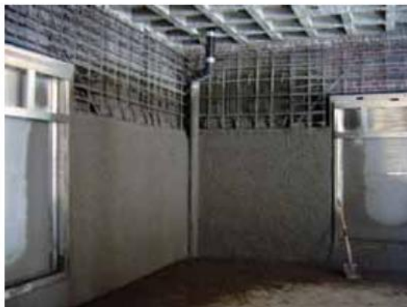
Rys. 6 Wzmacnianie ścian Uniwersytetu [8]
