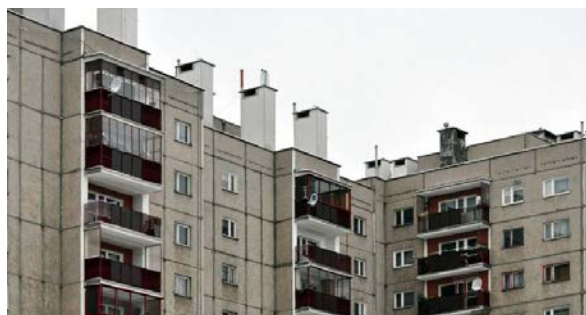
Rys. 2. Obiekt w systemie W-70
