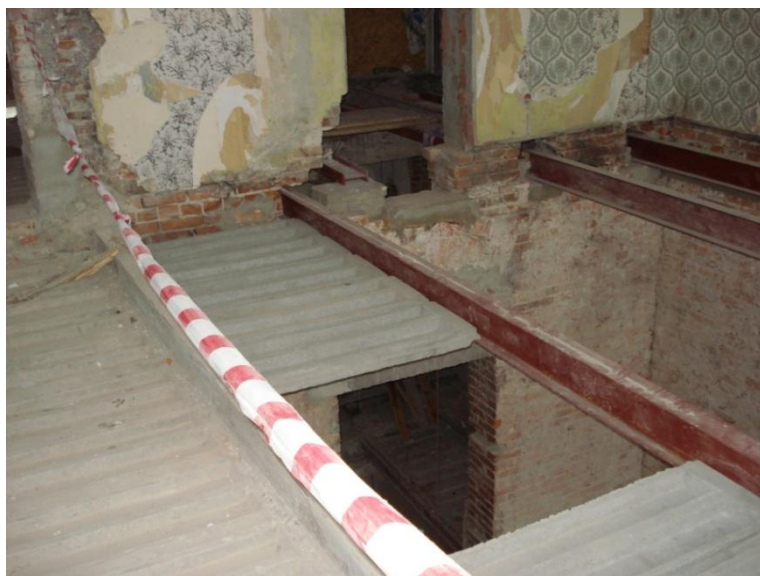
Rys. 6. Strop WPS w trakcie realizacji podczas wymiany całego stropu
