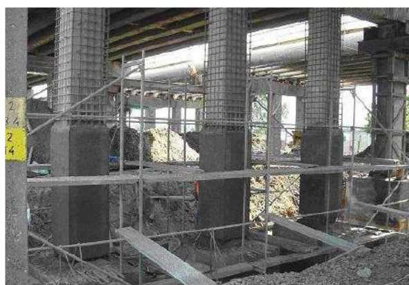
Rys. 4 Wzmacnianie słupów wiaduktu Błąd! Nie można odnaleźć źródła odwołania.
