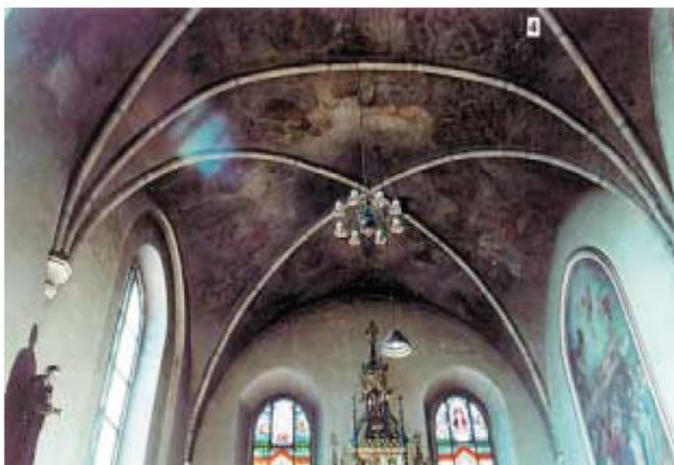
Rys. 1 Widok sklepienia od strony ołtarza [7]
