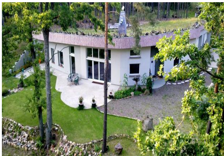
Rys. 3. Dom typu earthsheltered Zdzisława Bolanowskiego w Brzeziu [13]
