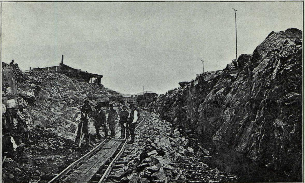
Herstellung der Fahrinne am Eisernen Thor durch Aussprengen im Trockenen.
