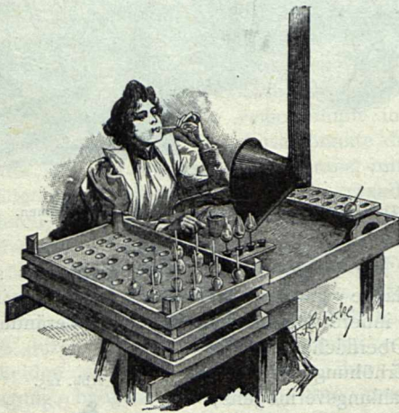
Das Einführen und Einschmelzen der Kohlenfäden in die Glasballons.
