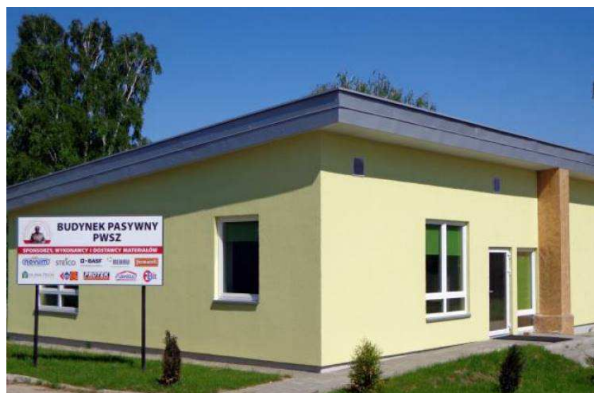
Rys.34. Budynek szkoleniowo-laboratoryjny „Dom pasywny”.
