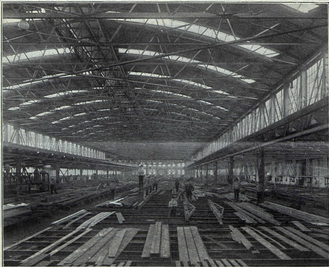
Montagehalle für den Brückenbau der Gutehoffnungshütte. Innenansicht.
