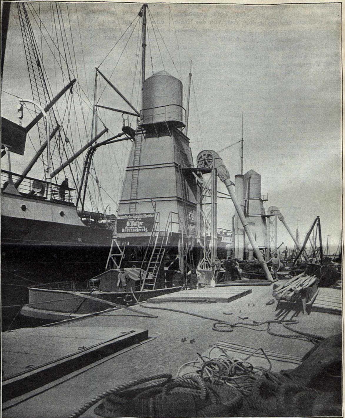
Der pneumatische Getreide-Elevator in Bremerhaven.
