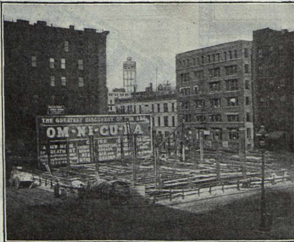
Beispiel der schnellen Aufführung eines Gebäudes in Amerika. Der Bauplatz des „Fisher Building“ in Chicago am 12. October 1897.
