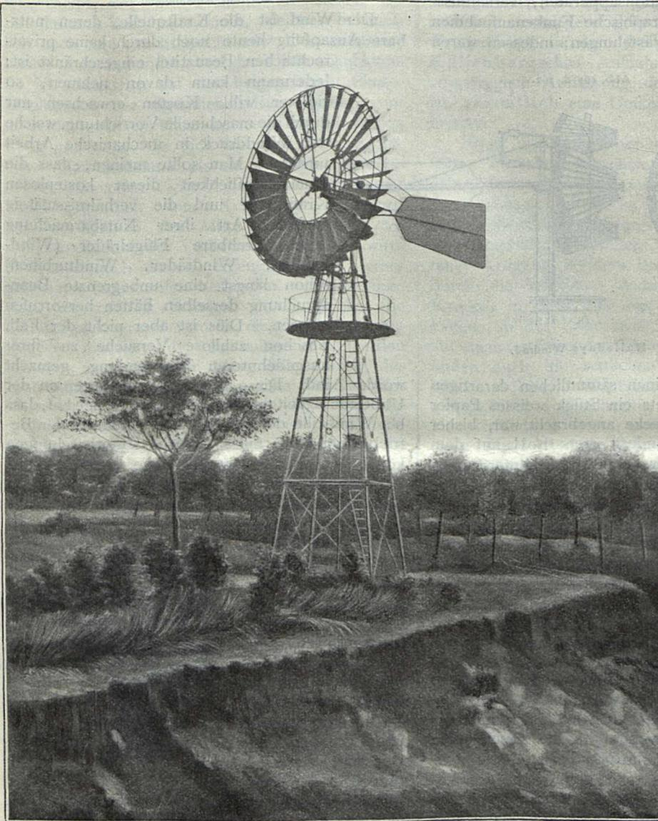
Windrad der Deutschen Windturbinen-Werke in Dresden von 5 m Durchmesser.
