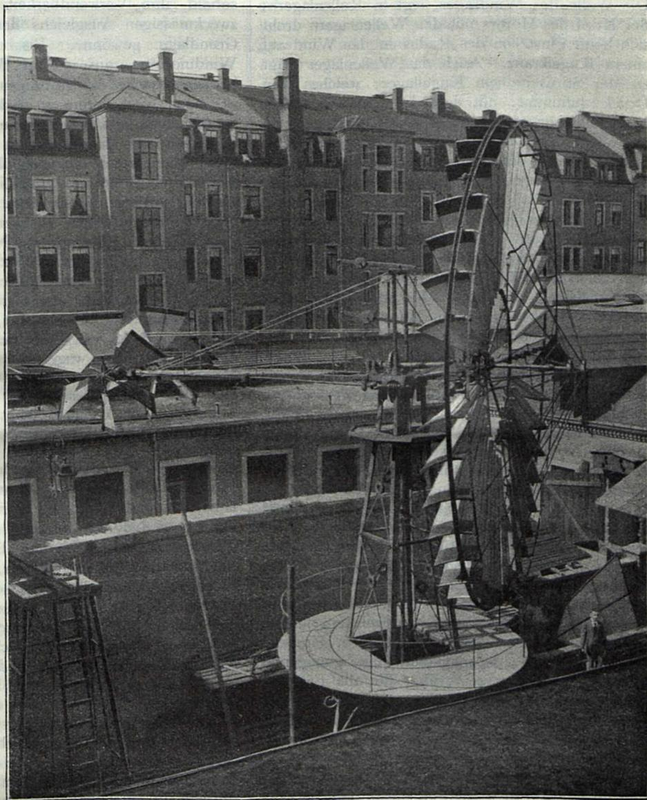
Windrad der Deutschen Windturbinen-Werke in Dresden von  $7\frac{1}{2}$  m Durchmesser.
