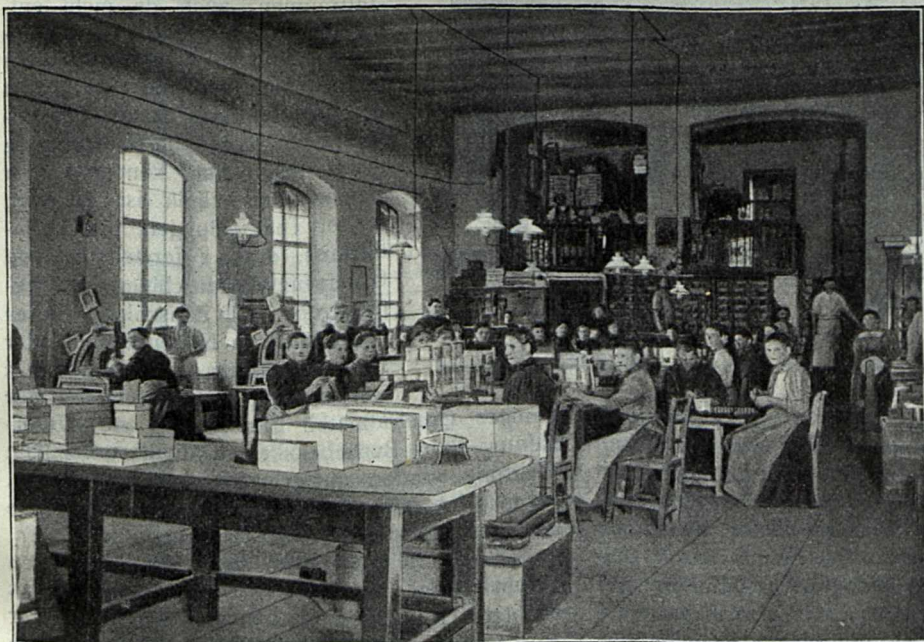
Parfümeriefabrik in Penzing (Verpackungsraum).
