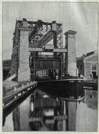
Schiffshebewerk bei Henrichenburg. Ausfahrt eines Schiffes aus dem Trog in die untere Kanalhaltung.
