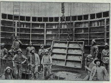
Bau des Schiffshebewerks bei Henrichenburg. Die Auskleidung eines Brunnenschachtes mit eisernen Ringen.
