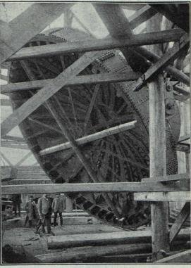
Bau des Schiffshebewerks bei Henrichenburg. Ansicht eines Schwimmers und des Bodens eines Schwimmers.
