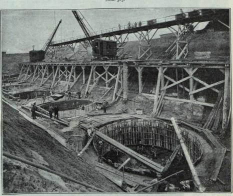
Bau des Schiffshebewerks bei Henrichenburg. Arbeiten zur Herstellung der Brunnenschächte.
