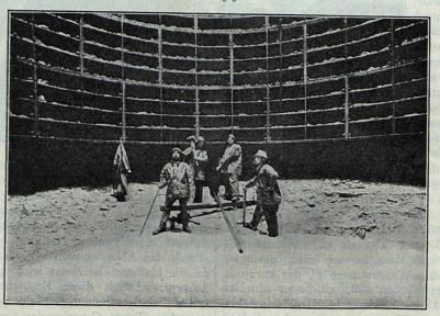
Bau des Schiffshebewerks bei Henrichenburg. Blick auf die Sohle eines Brunnenschachtes.
