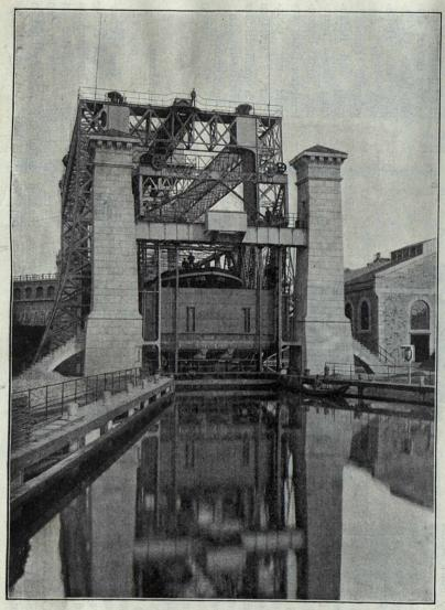
Schiffshebewerk bei Henrichenburg. Fahrt des Troges mit Schiff aus der oberen in die untere Kanalhaltung.
