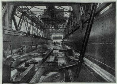
Bau des Schiffshebewerks bei Henrichenburg. Durchsicht durch den in der Herstellung begriffenen Schleusentrog.
