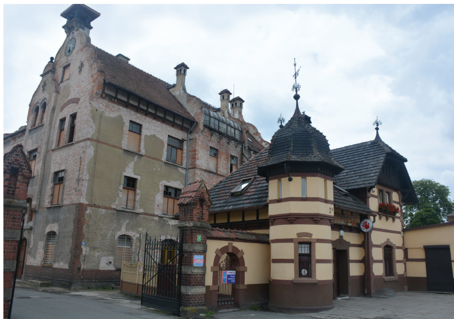
II. 9. Budynek dawnej fabryki porcelany w Tułowicach (fot. P. Gerber, 2017)
