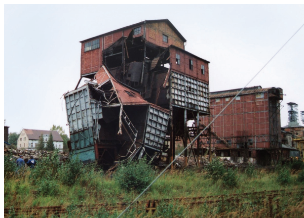
Il. 2. Budynki koksowni Biały Kamień w Wałbrzychu w trakcie wyburzania w 1996 r. (fot. P. Gerber)
