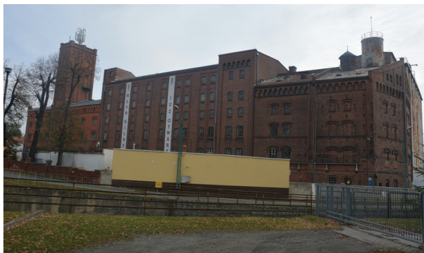
Il. 7. Widok budynków Młyna Hilberta w Dzierżoniowie od strony zachodniej (fot. P. Gerber, 2019)
