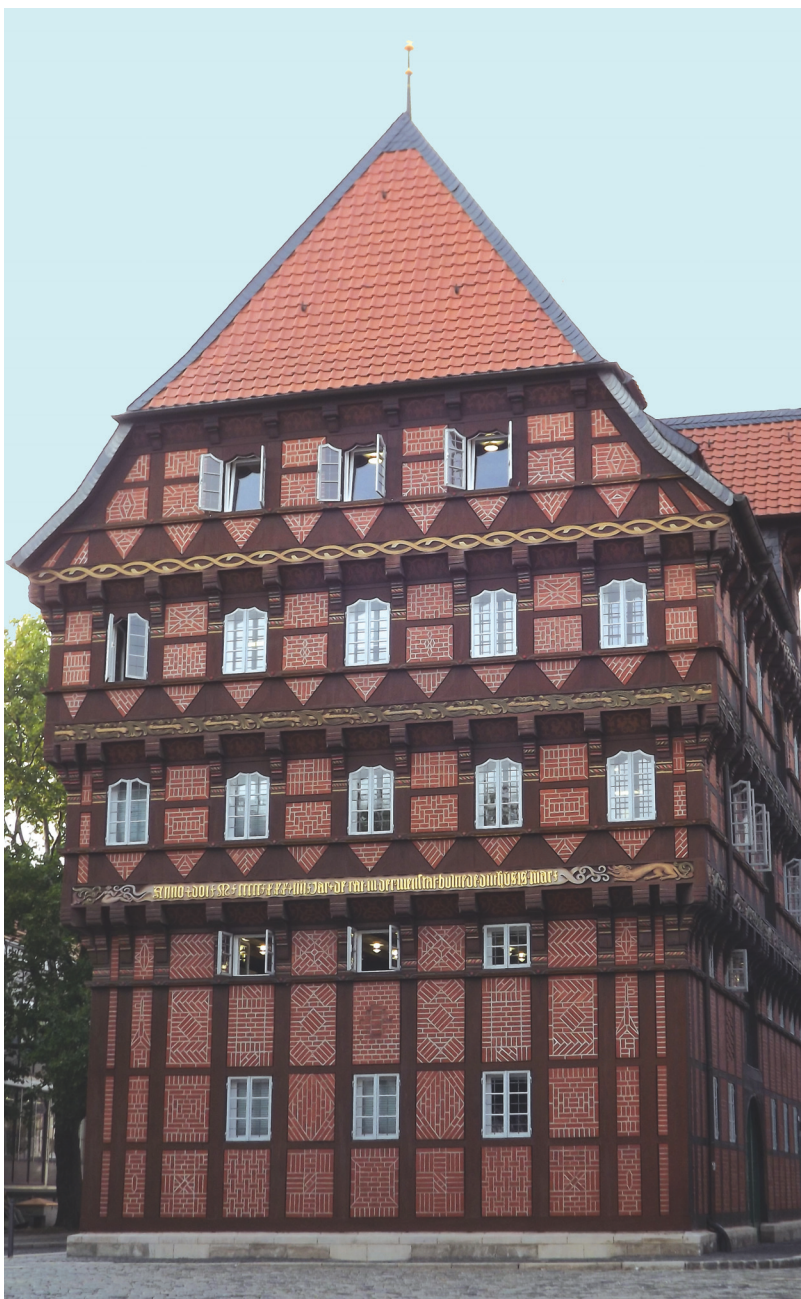
Dom Wagi w Braunschweig z ozdobnymi wypełnieniami fachów przez zastosowanie zmiennego wążku cegły (fot. D. Kowalska)
