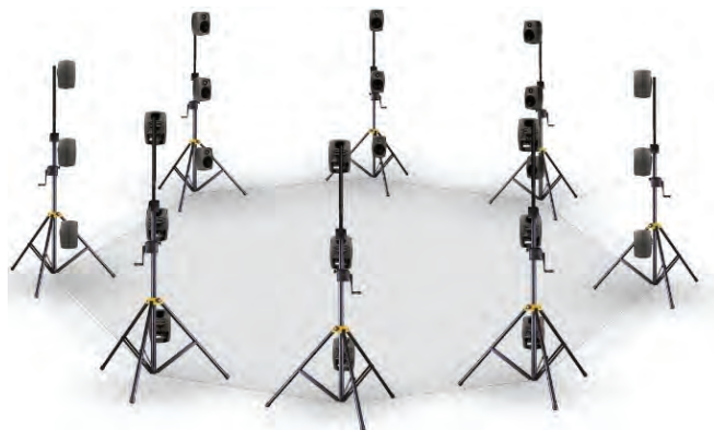
Rys. 5. Instalacja ambisoniczna laboratorium Działu Nowych Mediów Poznańskiego Centrum Superkomputerowo-Sieciowego
