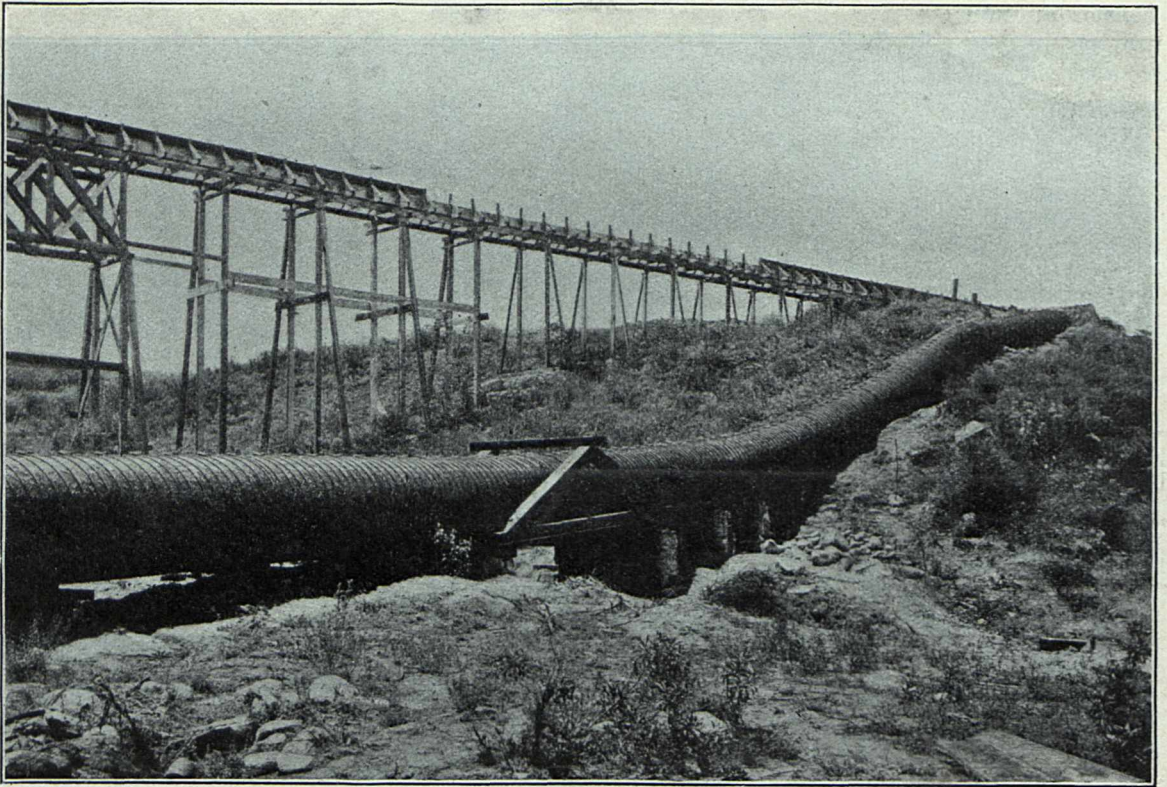
Das Druckrohr des Santa Ana-Kanals, oben das alte aufgegebene offene Gerinne.
