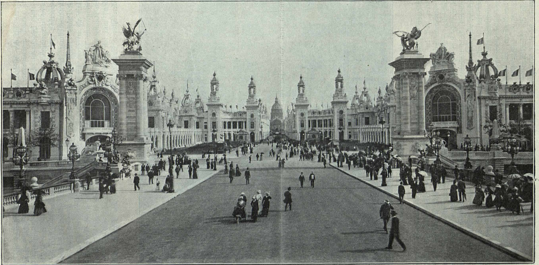
Die Weltausstellung in Paris. Ansicht der Esplanade des Invalides von dem Pont Alexandre III. aus.
