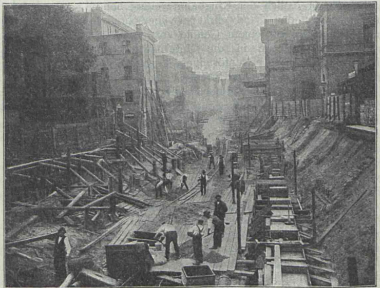
Gesamtsansicht der Baustelle des Einganges zur Unterpflasterbahn.
