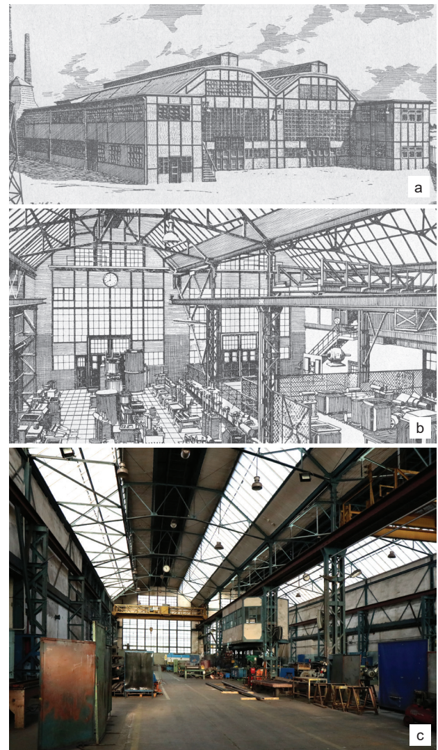
Fig. 6. Building of the mechanical workshop Mechanische Werkstätten Schlesien GmbH:
