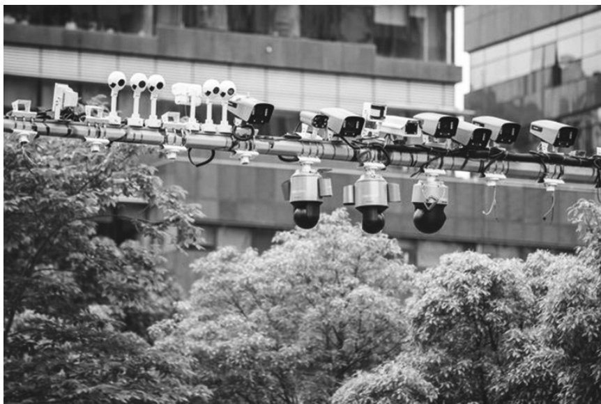
Fotografia 1.1. Infrastruktura monitoringu miejskiego w Hangzhou
