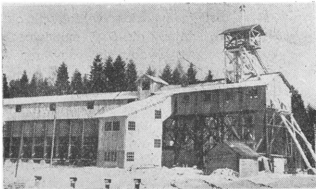
Kopalnia „STANISŁAW”. Szyb Centralny, głęb. 74 m z pomostem nadszybowym. Szyb przystosowany do jazdy liną (zjazd ludzi).
