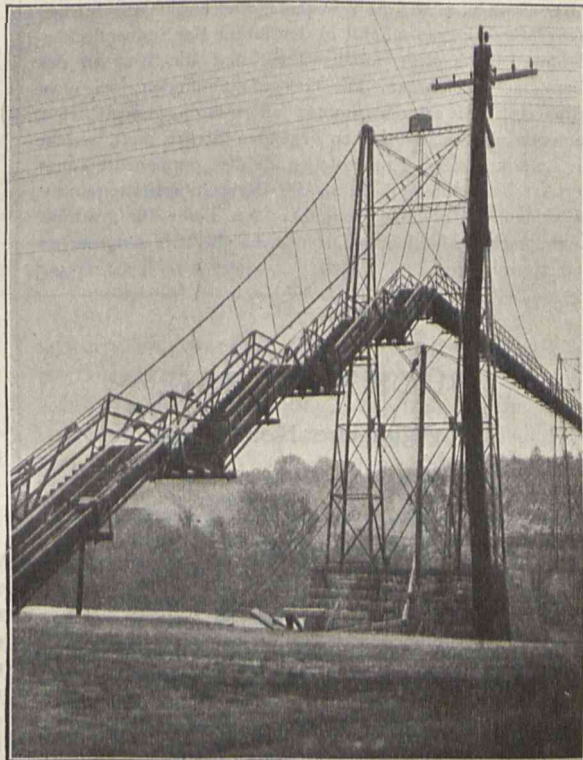
Fussgänger - Hängebrücke mit Stufentreppe.
