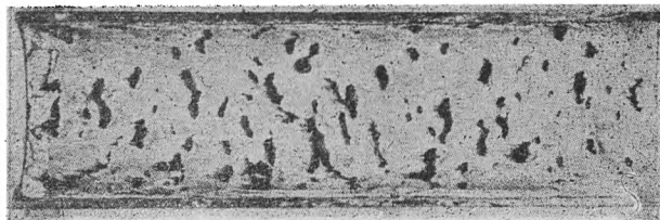
Rys. 1. Korozja lokalna rury miedzianej
