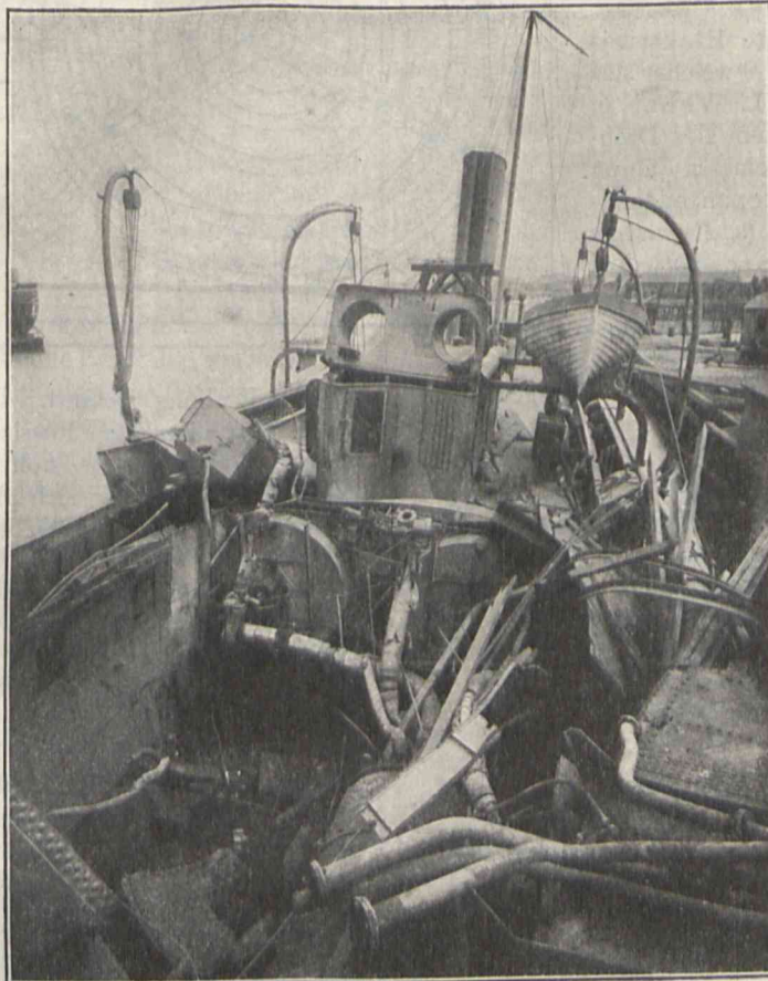
Ansicht von vorne in das Innere eines türkischen Torpedobootsjägers, gebaut auf der Germania, Kiel. Auf der Probefahrt explodirte in Folge Wassermangels ein Kessel; trotz der ungeheuren Zerstörung wurde das Fahrzeug nicht leck und es konnte in kurzem wieder hergestellt werden.
