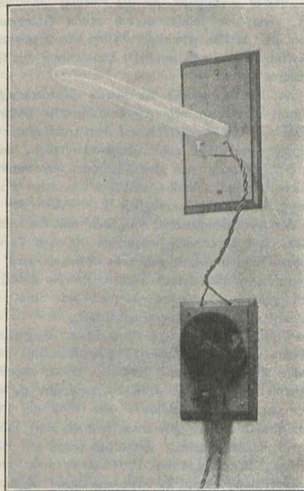
Die Quecksilberdampf-Lampe von Cooper Hewitt.
