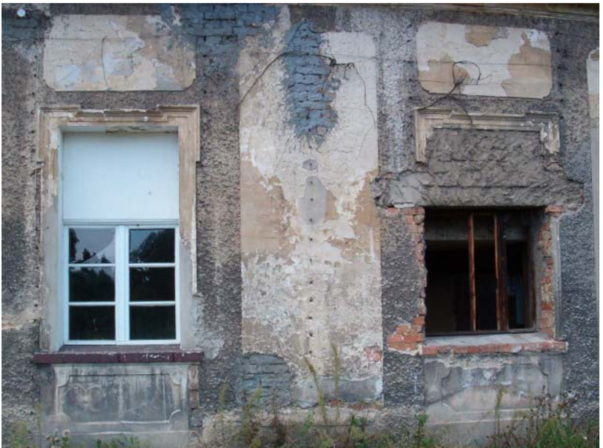
Fot. 87. Okna elewacji ogrodowej oficyny 1 – skrzydło południowe.
