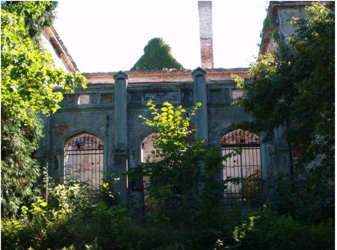
Fot. 14. Elewacja północna (neogotycka elewacja sali balowej).
