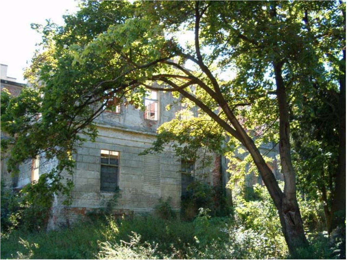
Fot. 15. Elewacja północna (wschodnia 3-osiowa partia boczna).
