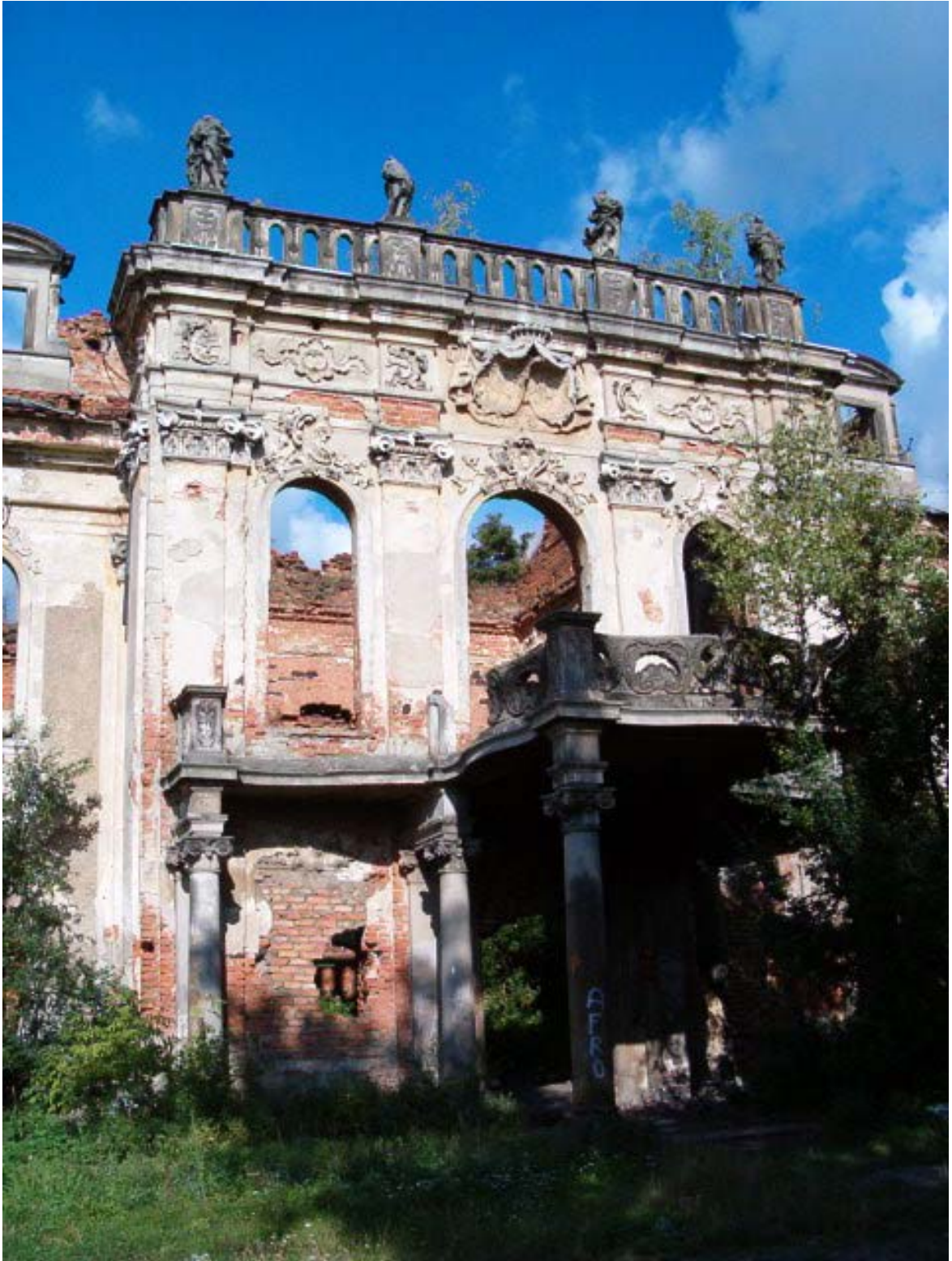
Fot. 71. Ryzalit środkowy z kolumnowym portykiem (elewacja frontowa).
