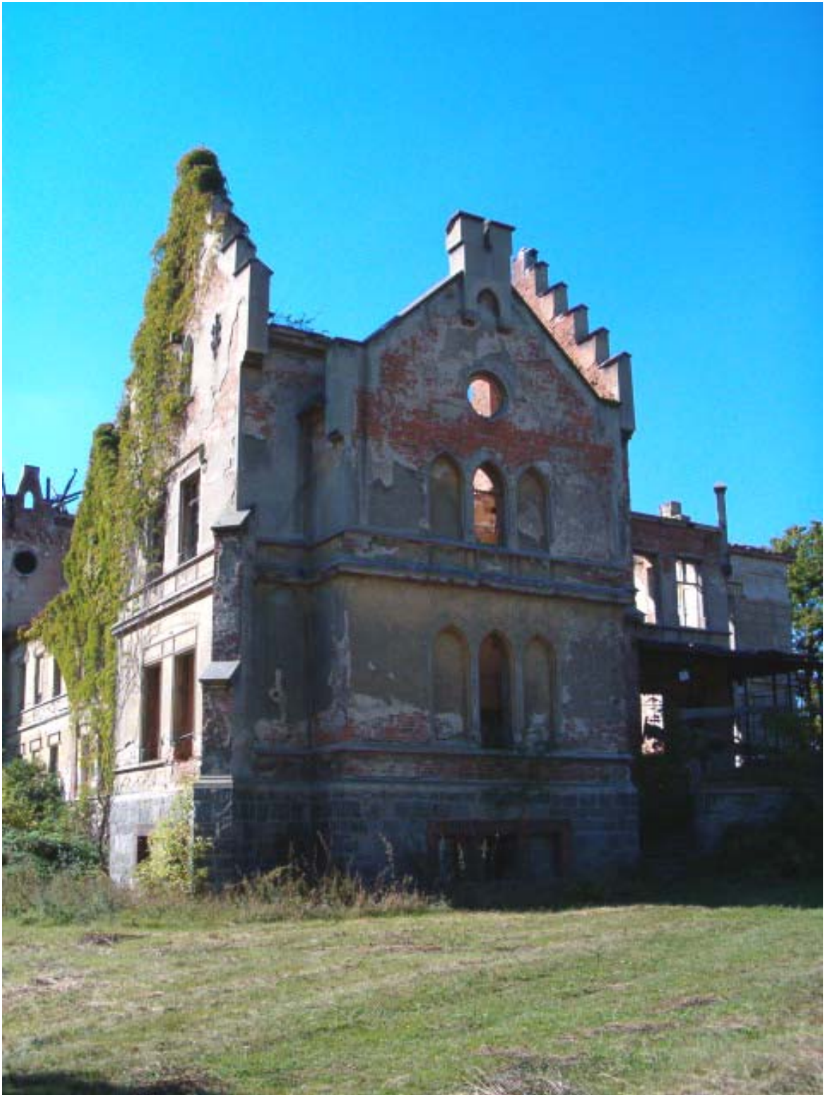
Fot. 19. Elewacja wschodnia południowo-wschodniej wieży.
