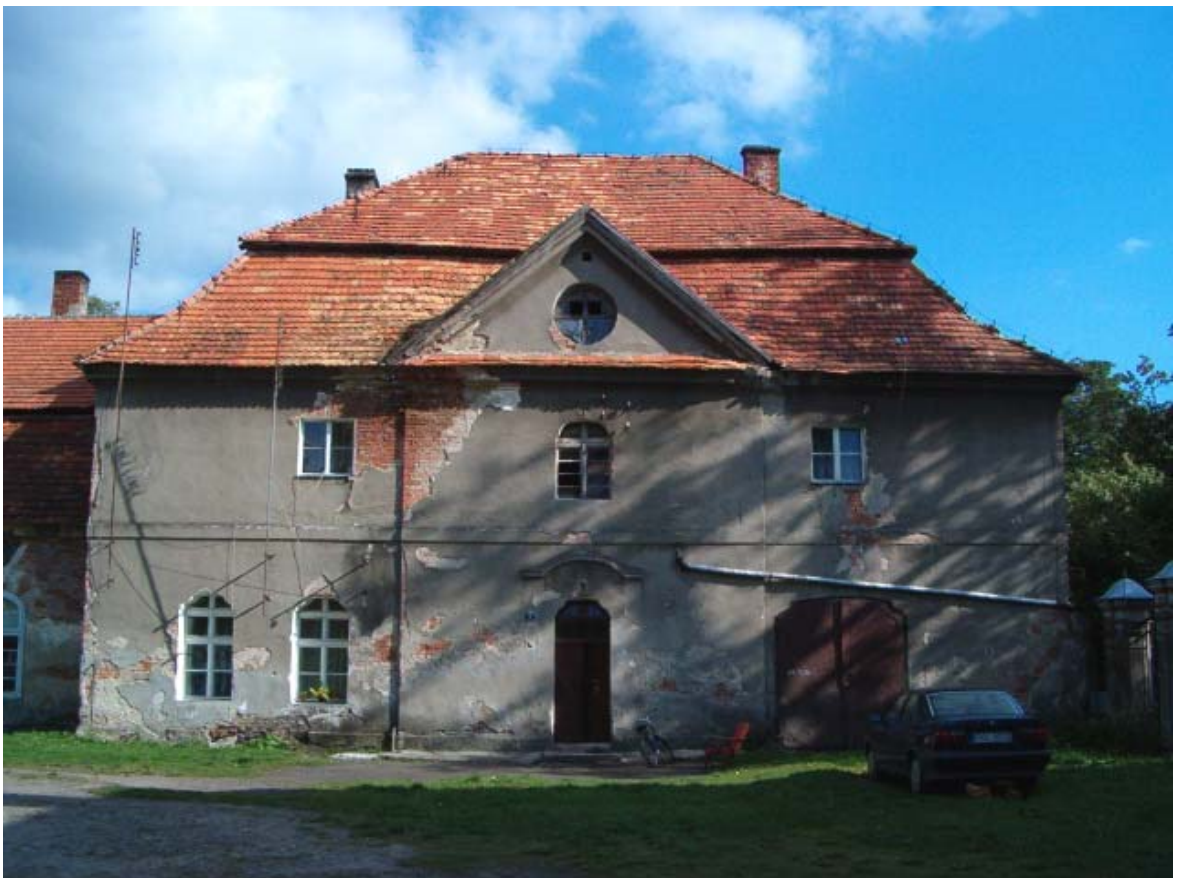
Fot. 81. Oficyna 4 skrzydła południowego.
