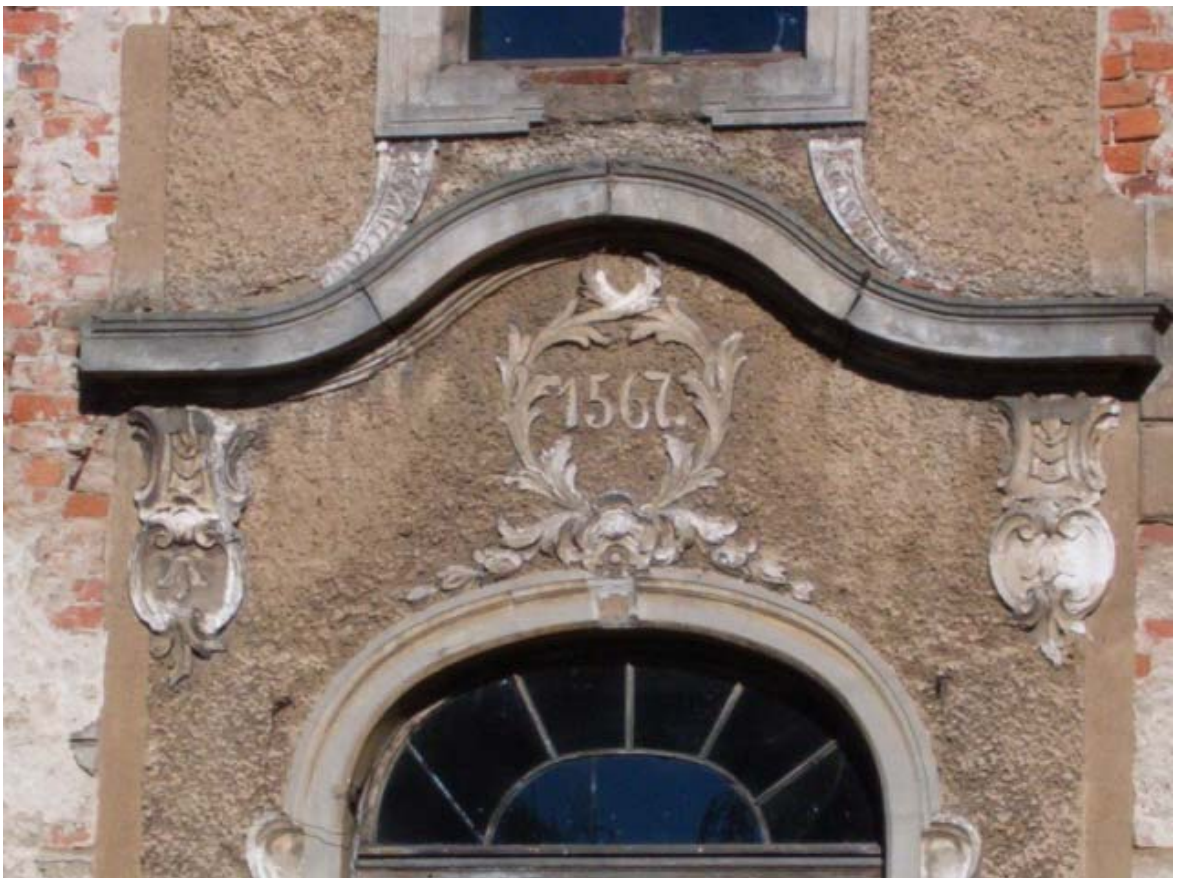
Fot. 40. Detal dekoracji nadokiennej elewacji frontowej skrzydła wschodniego (oś IV od prawej).
