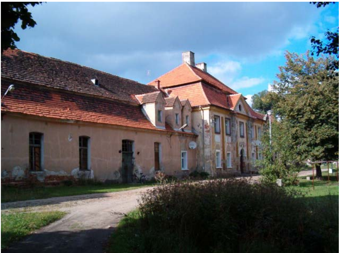
Fot. 83. Stajnie (oficyna 3) w skrzydle północnym. W dali – dom gościnny.
