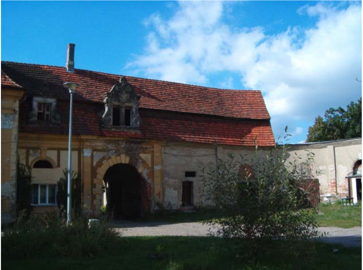
Fot. 73. Oficyna 1 skrzydła północnego z boczną bramą przejazdową.
