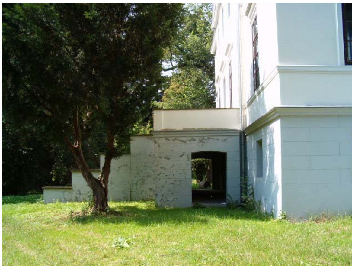
Fot. 138. Ganek przy południowo-zachodniej (ogrodowej) elewacji pałacu.
