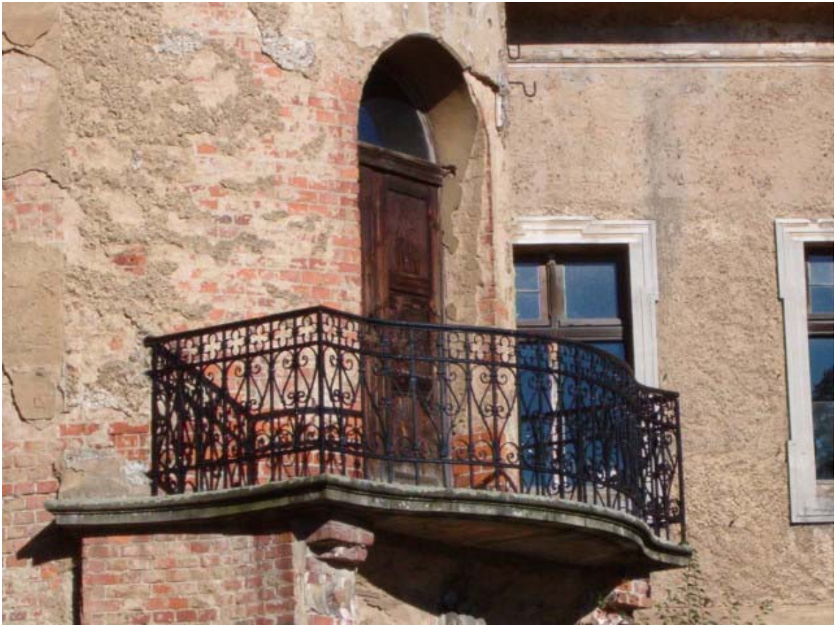
Fot. 42. Balkon nad wejściem głównym.
