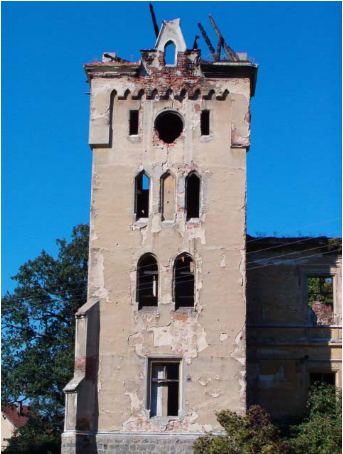
Fot. 24. Elewacja południowa południowo-zachodniej wieży.
