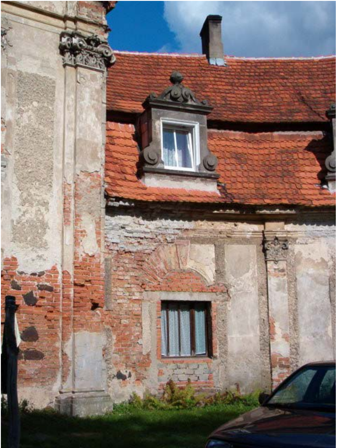
Fot. 76. Skrzydło południowe przy korpusie głównym pałacu.
