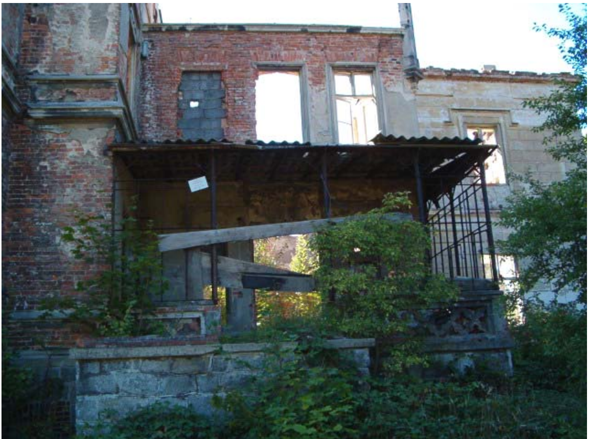
Fot. 18. Przybudówka z werandą we wschodniej elewacji pałacu.
