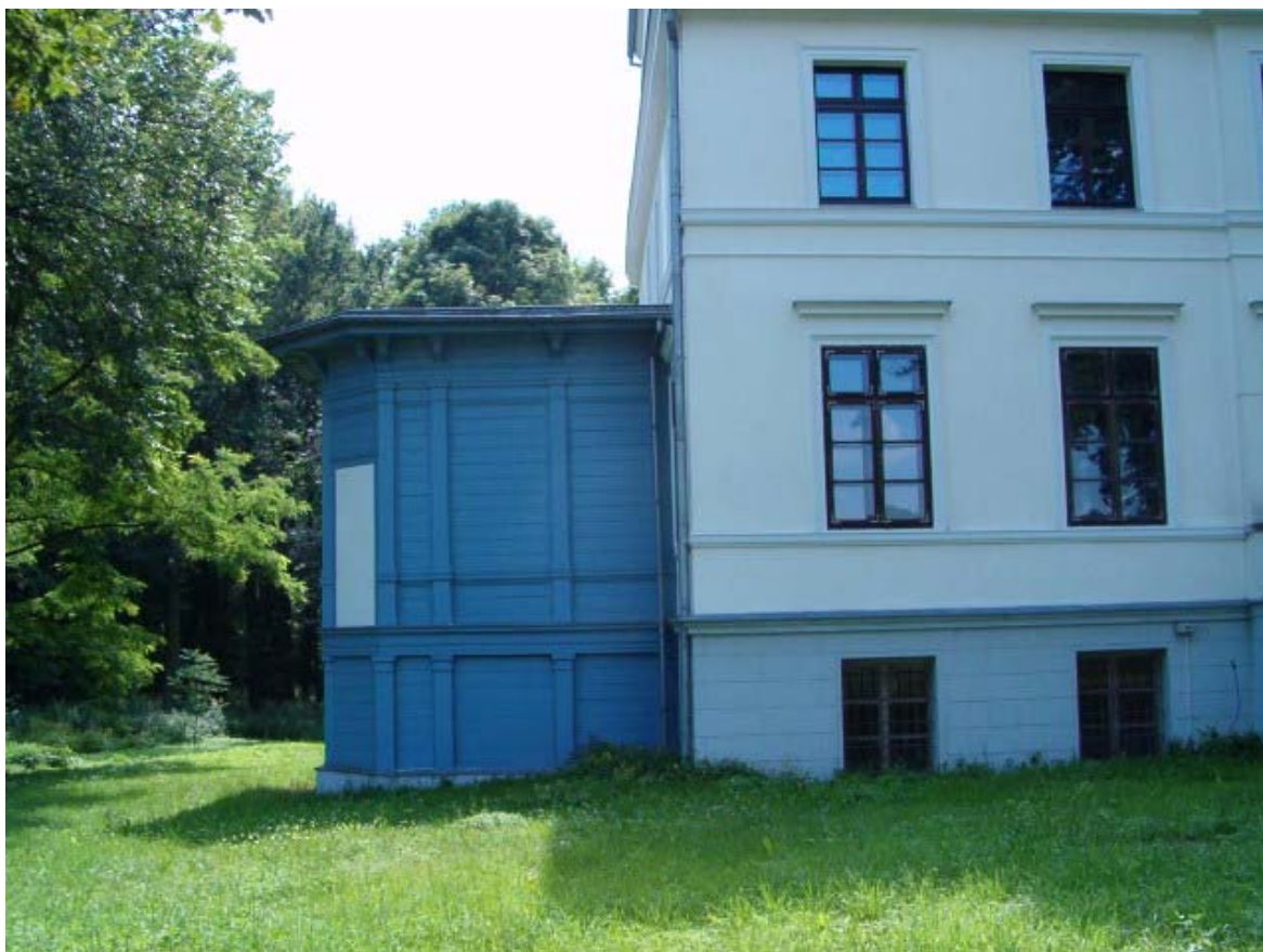
Fot. 142. Północna elewacja drewnianej werandy.
