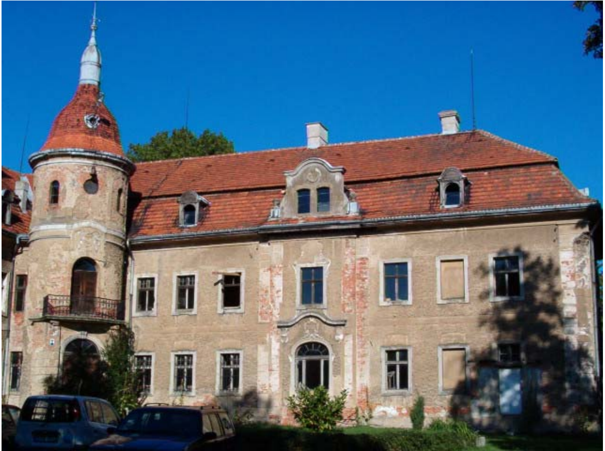
Fot. 39. Elewacja zachodnia (frontowa) skrzydła wschodniego.
