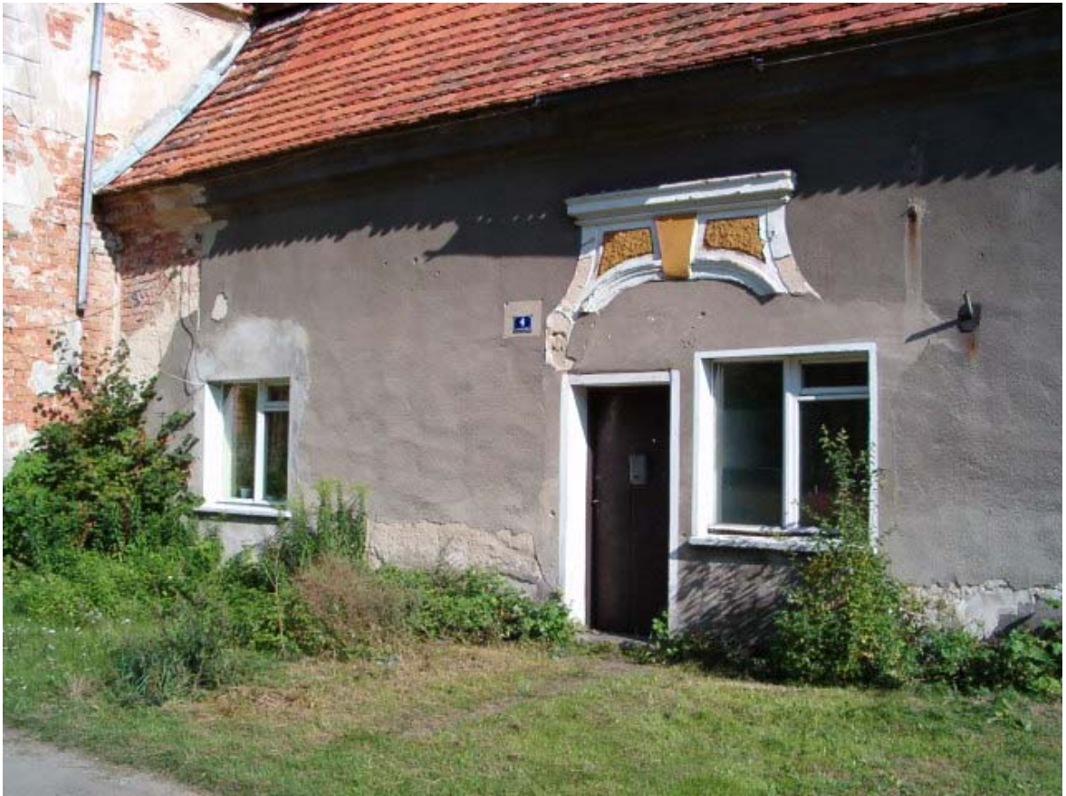
Fot. 80. Oficyna 3 skrzydła południowego. Widoczne zmiany otworów okiennych i drzwiowych.
