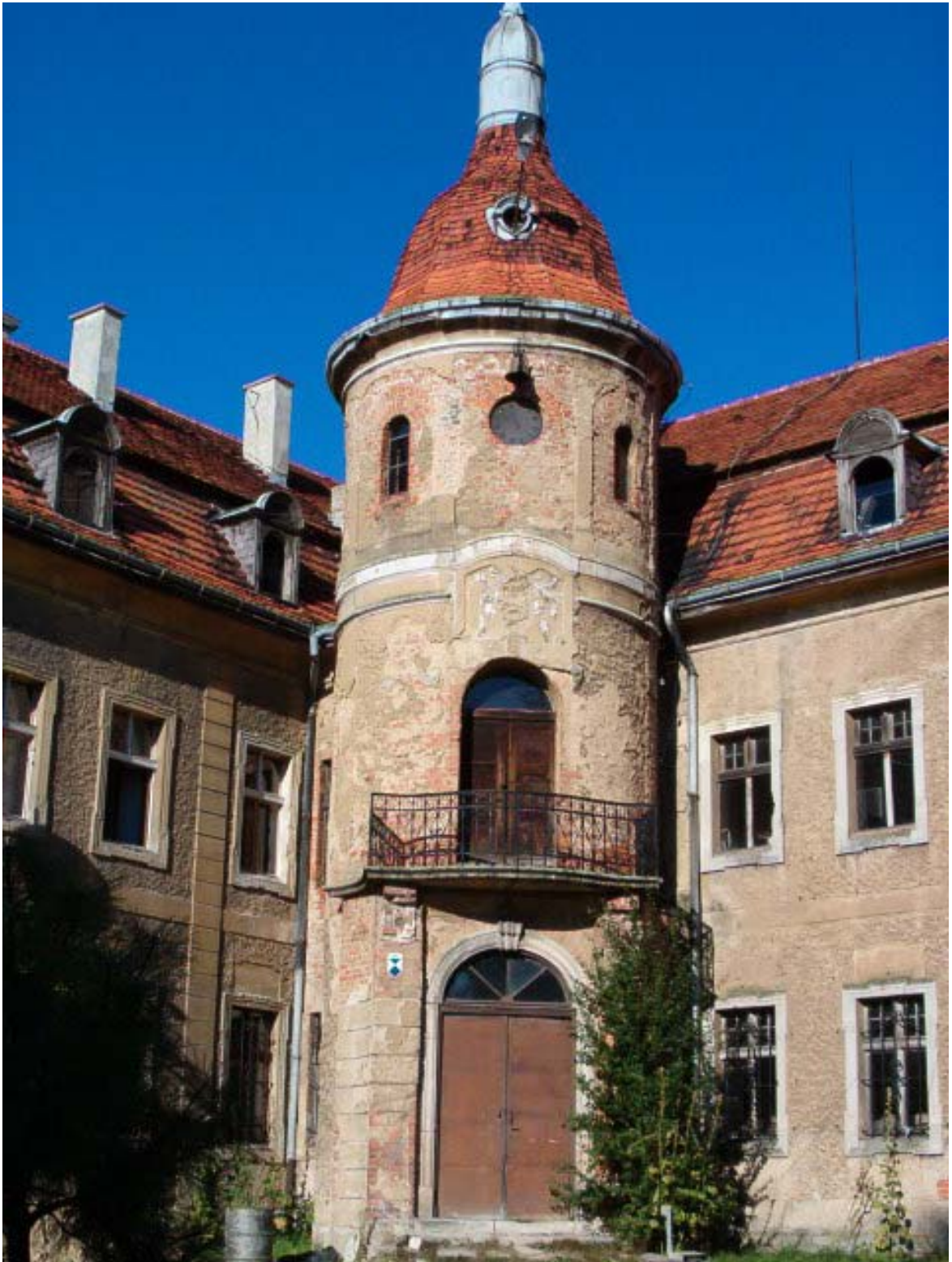
Fot. 41. Cylindryczna wieża.
