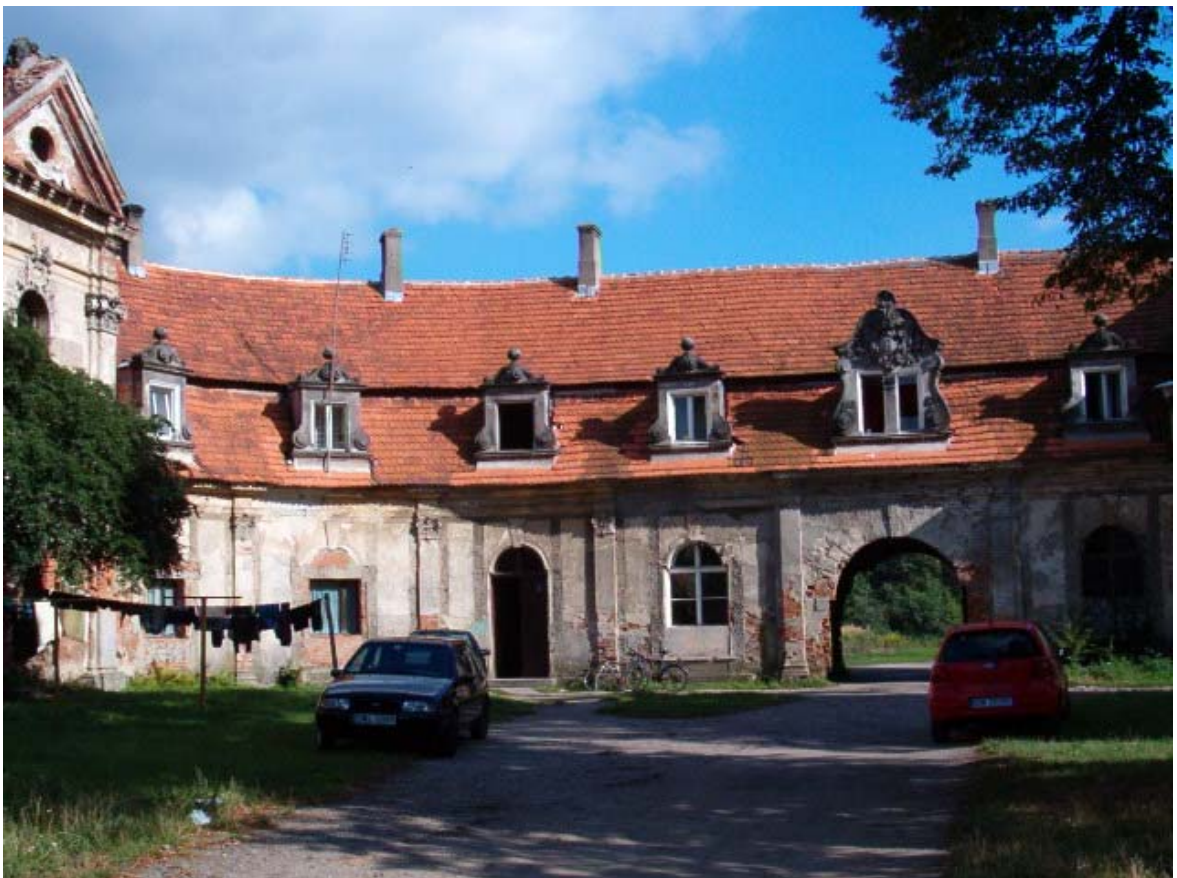
Fot. 74. Oficyna 1 skrzydła południowego.
