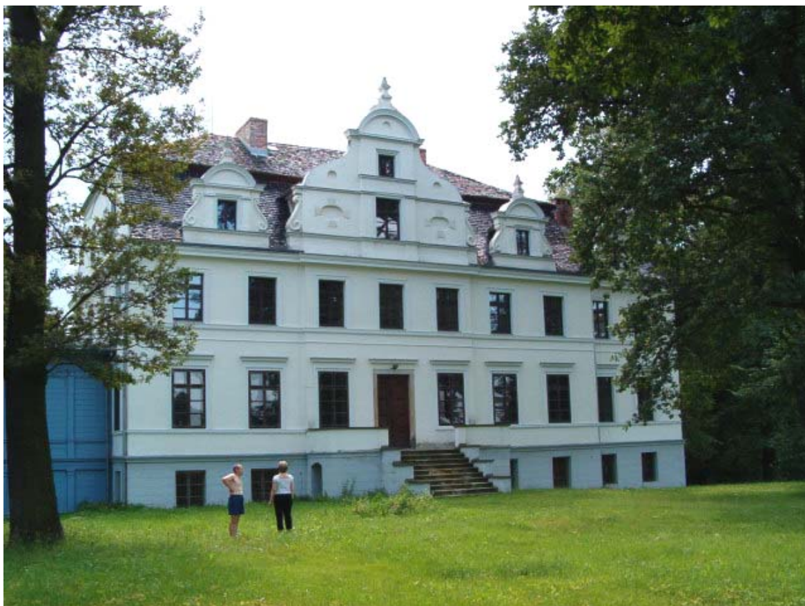
Fot. 135. Elewacja północno-wschodnia (frontowa).
