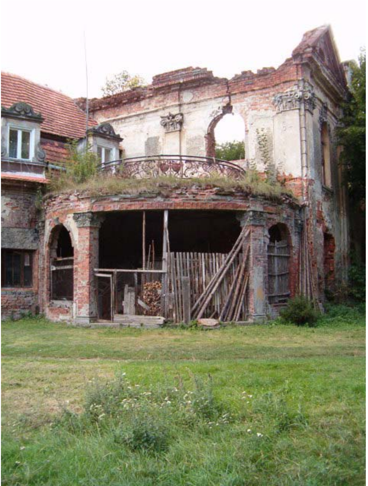
Fot. 88. Weranda ogrodowa.
