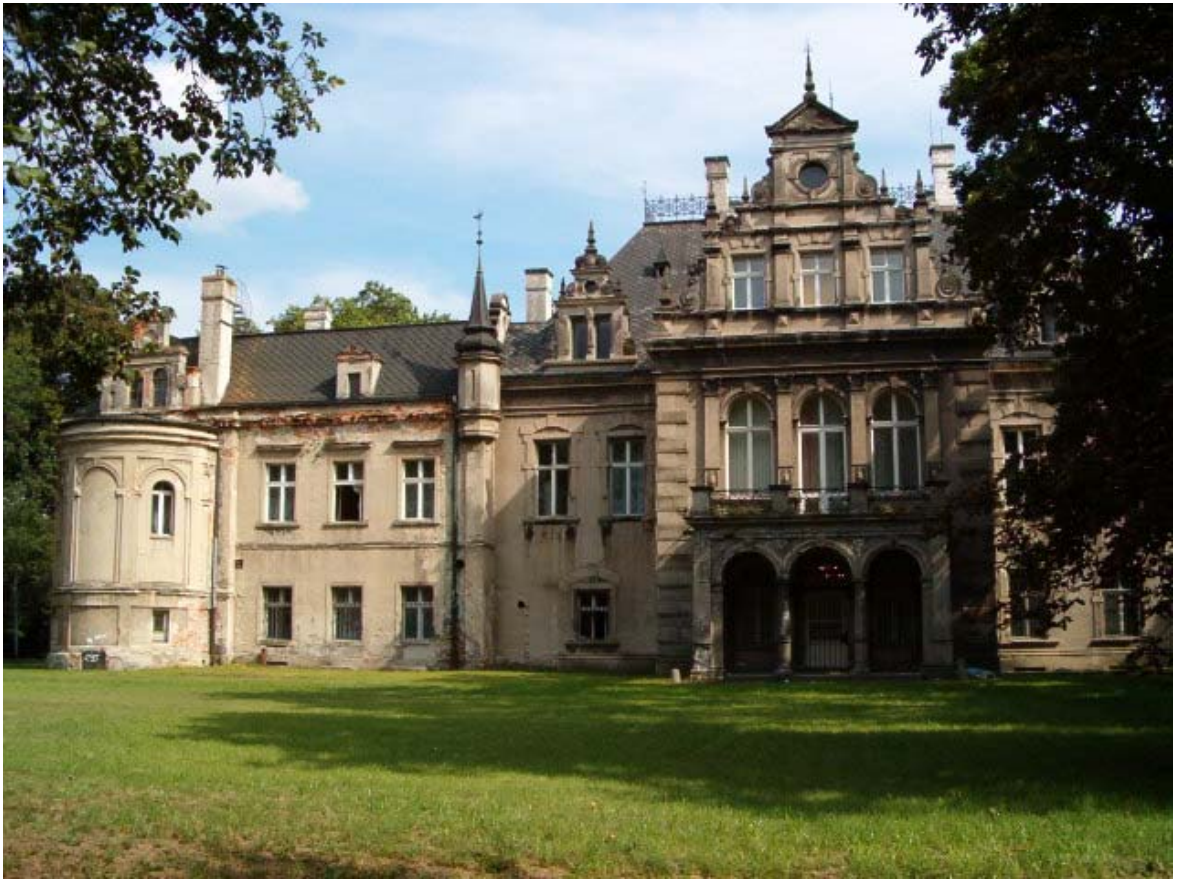
Fot. 111. Elewacja zachodnia (ogrodowa).
