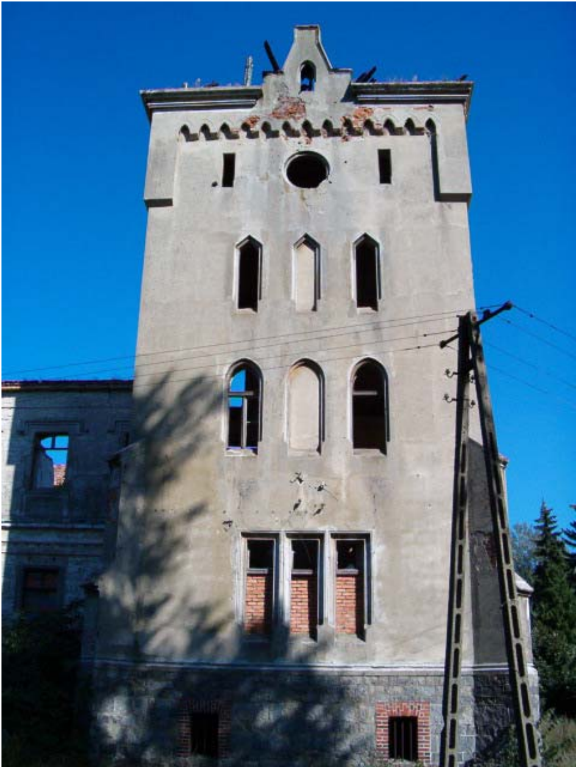
Fot. 25. Elewacja zachodnia południowo-zachodniej wieży.
