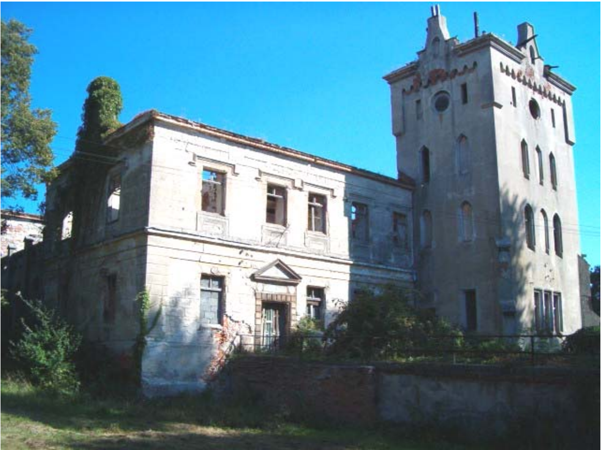
Fot. 8. Korpus główny z południowo-zachodnią wieżą.
