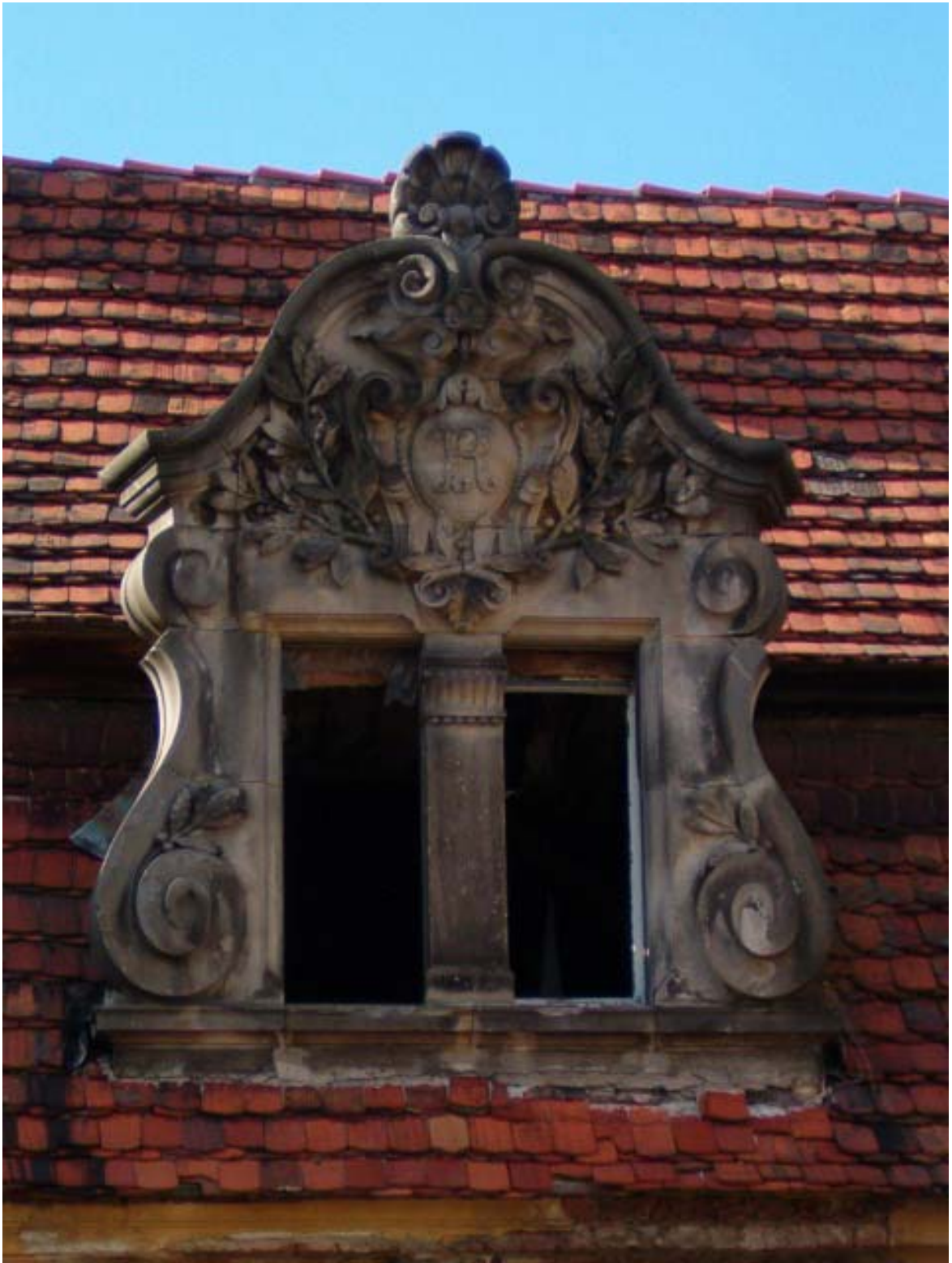
Fot. 75. Facyata występująca nad bocznymi bramami przejazdowymi od strony dziedzińca.
