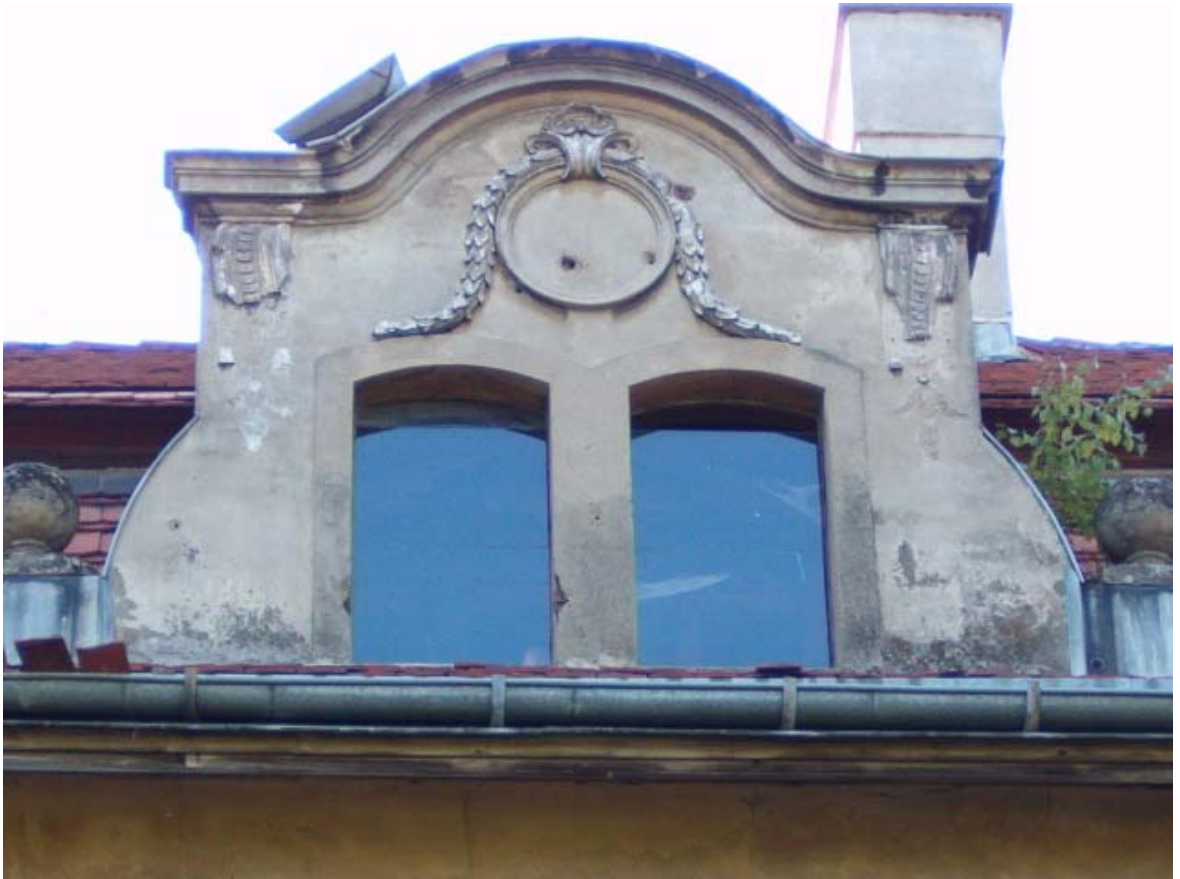
Fot. 53. Dwuosiowa facjata występująca w elewacjach frontowych i elewacji wschodniej.
