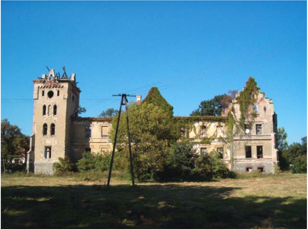
Fot. 21. Elewacja południowa.
