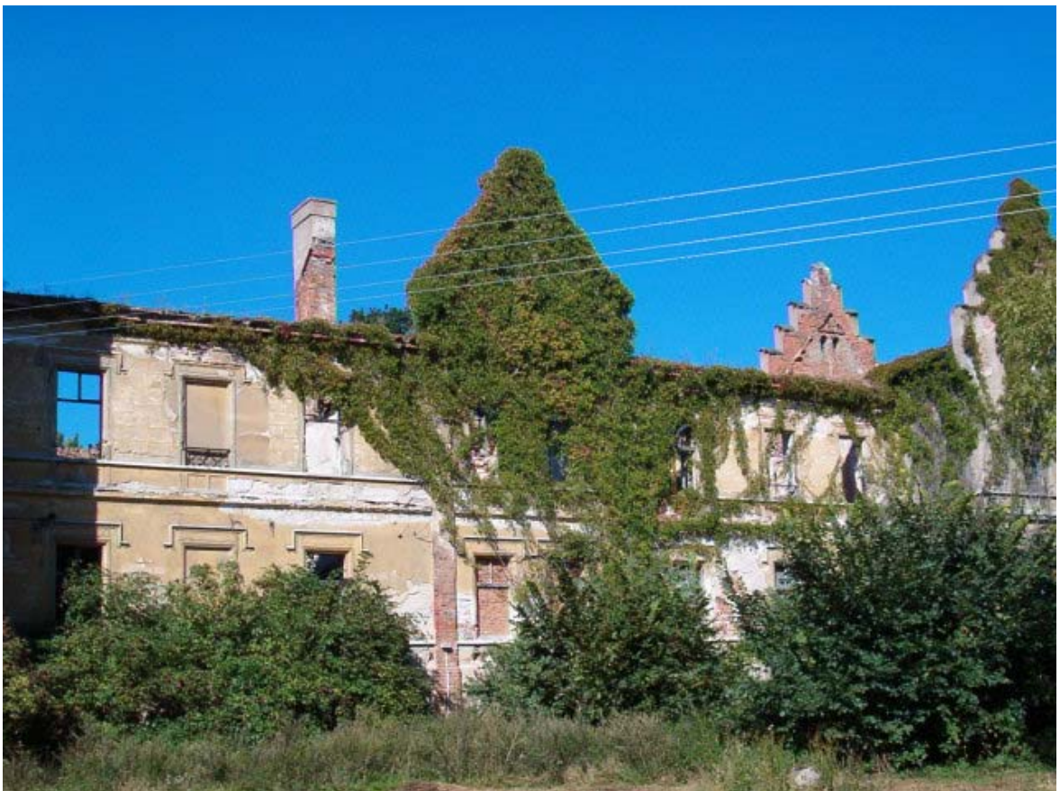
Fot. 22. Elewacja południowa korpusu głównego.
