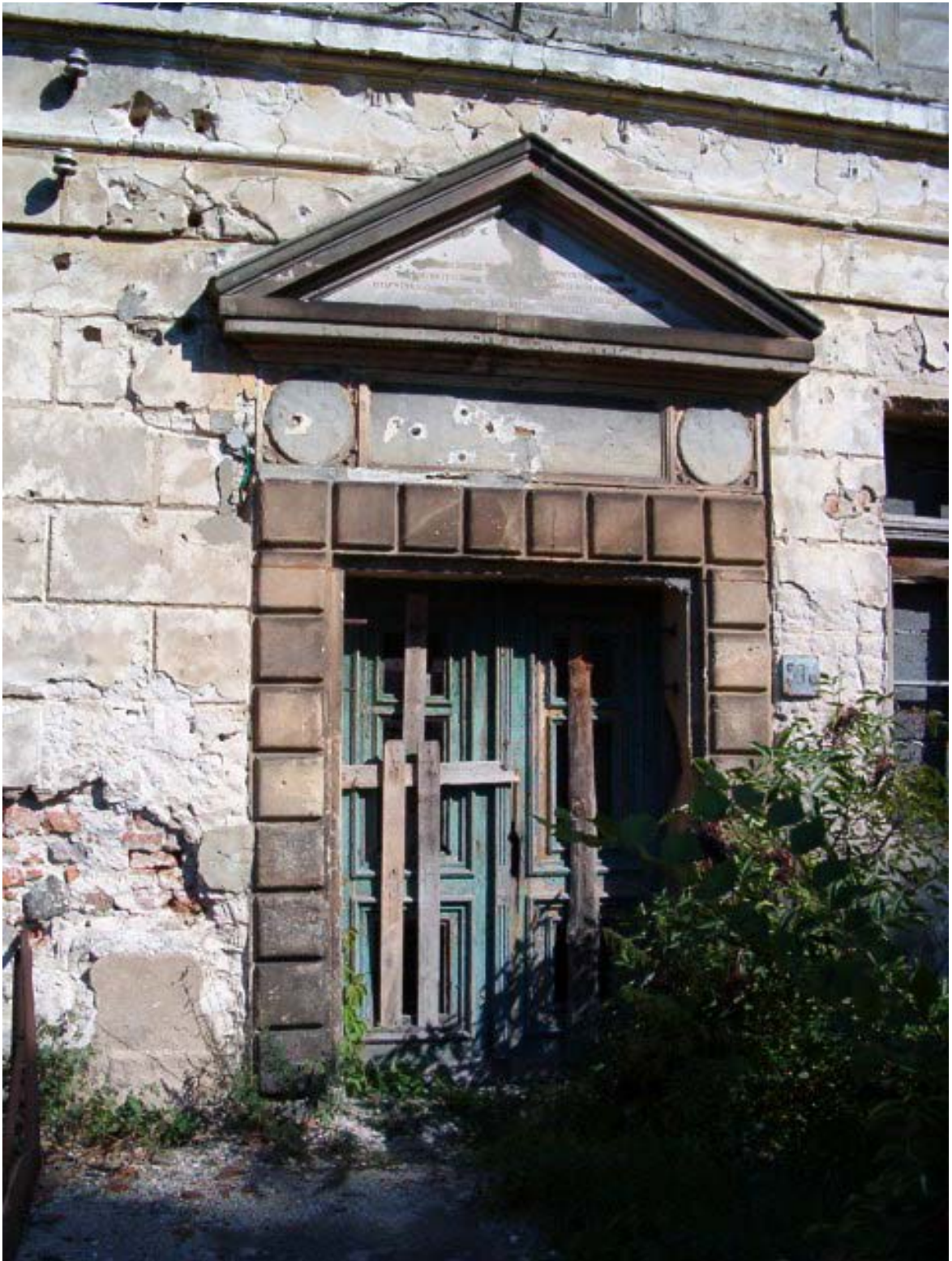
Fot. 9. Główne wejście.
