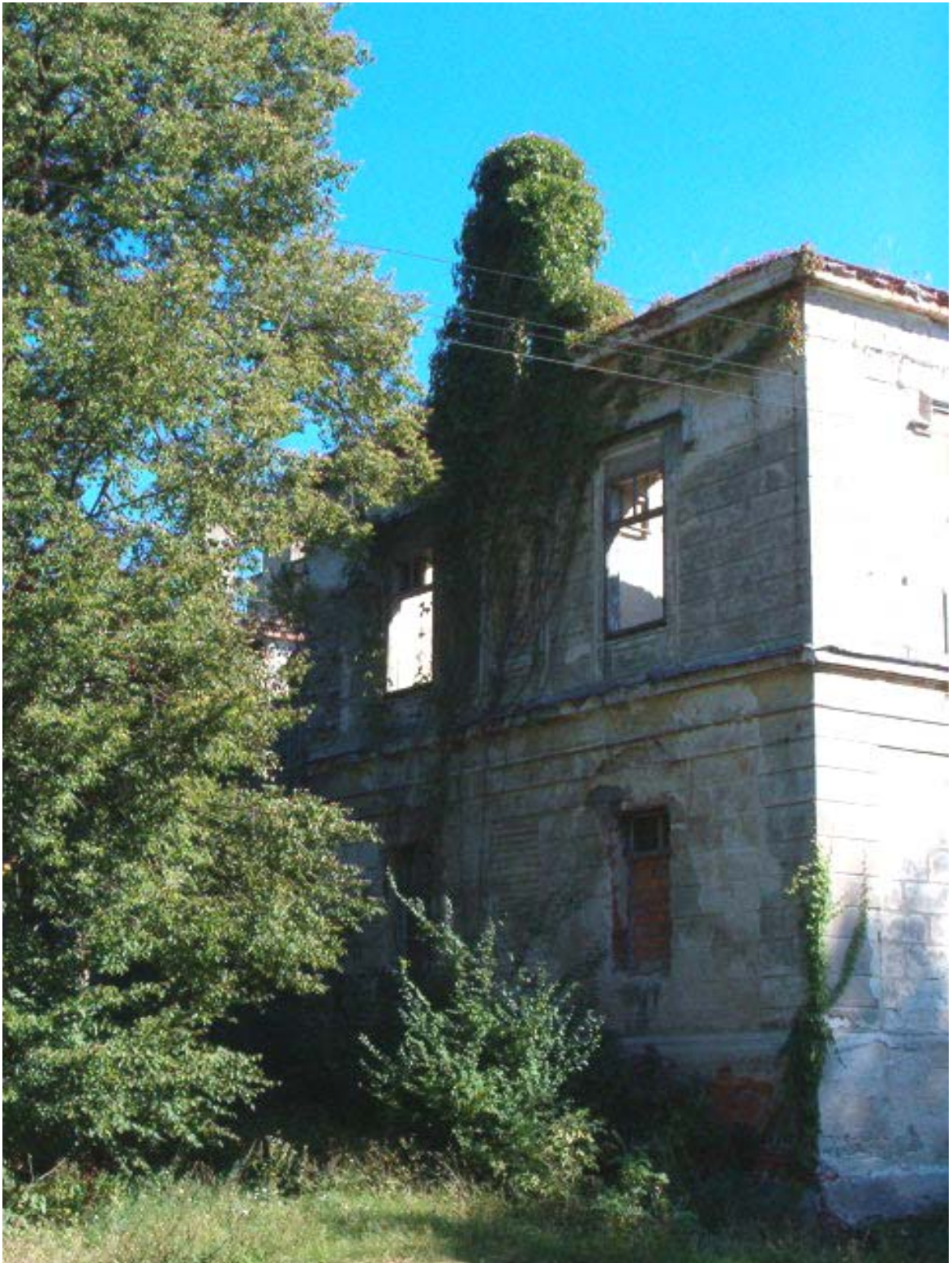
Fot. 12. Elewacja północna (zachodnia 3-osiowa partia boczna).
