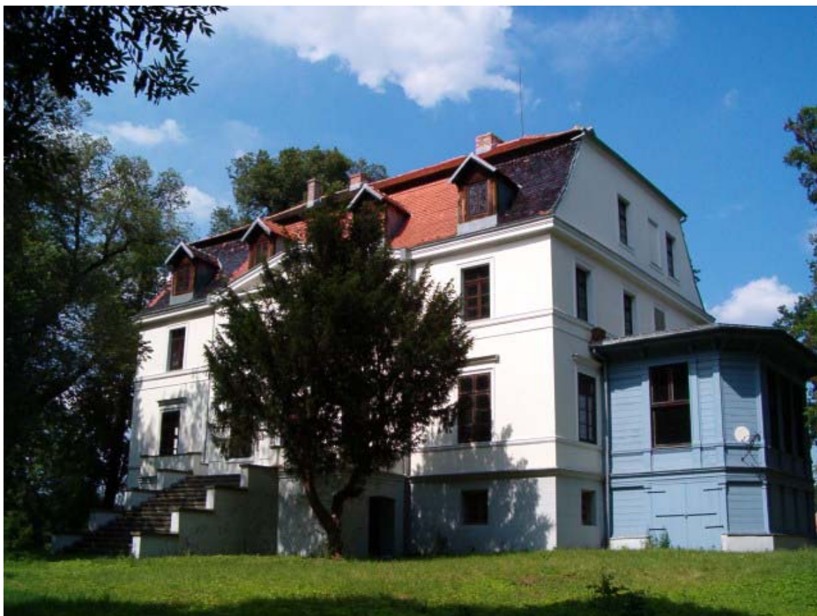
Fot. 137. Elewacja południowo-zachodnia (ogrodowa).
