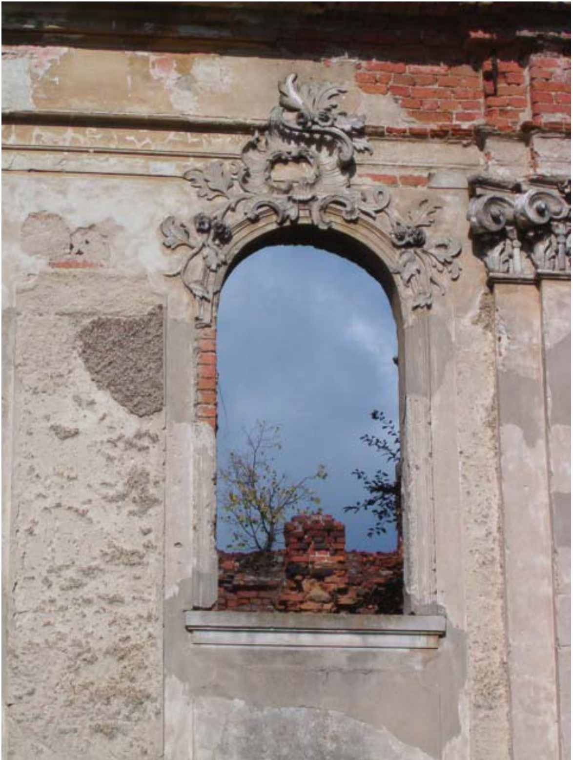
Fot. 72. Detal dekoracji okiennej jednego z okien elewacji frontowej. W kluczu okna – roccaille.
