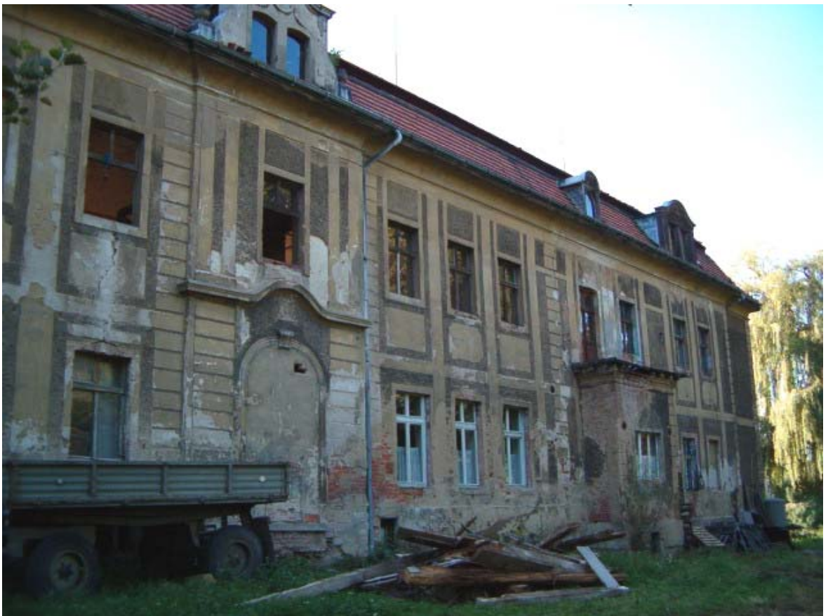
Fot. 48. Elewacja wschodnia (ogrodowa).
