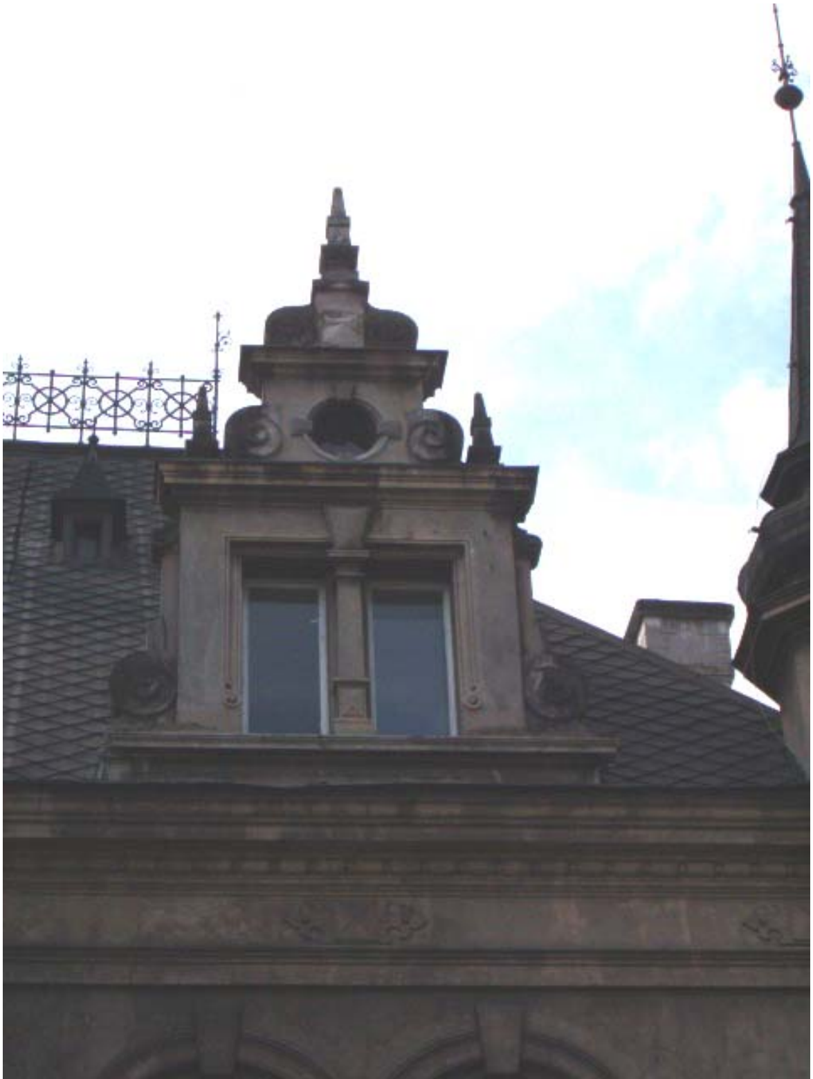
Fot. 110. Dwuosiowa facyata elewacji frontowej.
