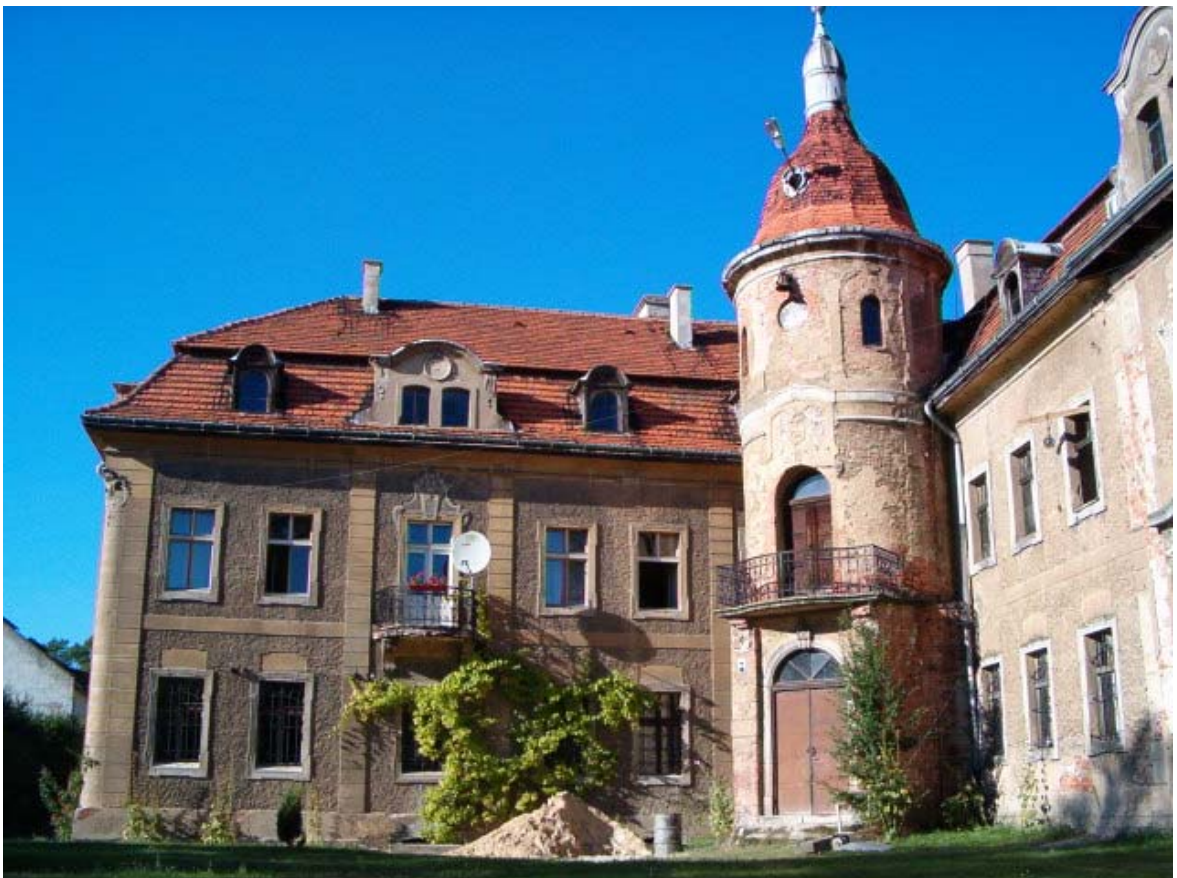
Fot. 43. Elewacja południowa (frontowa) skrzydła północnego.
