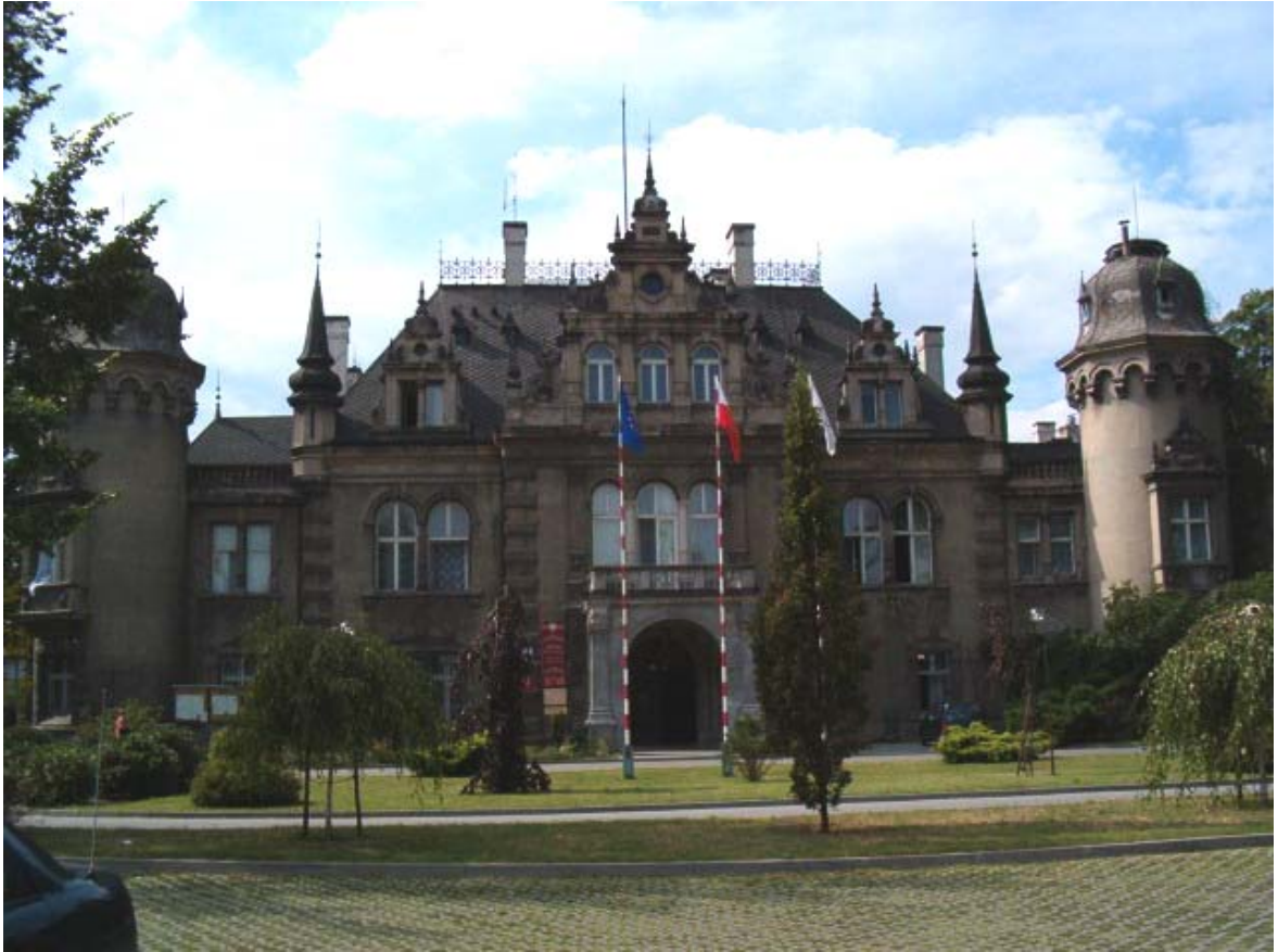
Fot. 107. Elewacja południowo-wschodnia (frontowa).
