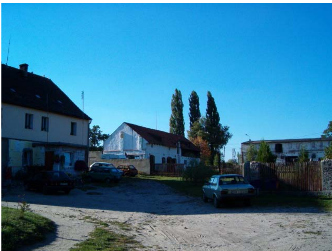
Fot. 56. Zabudowa folwarczna. Widok od strony wjazdu.
