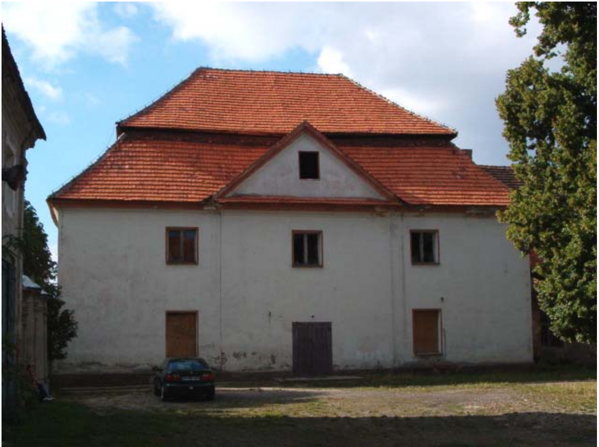
Fot. 82. Ujeżdżalnia (oficyna 4) w skrzydle północnym.
