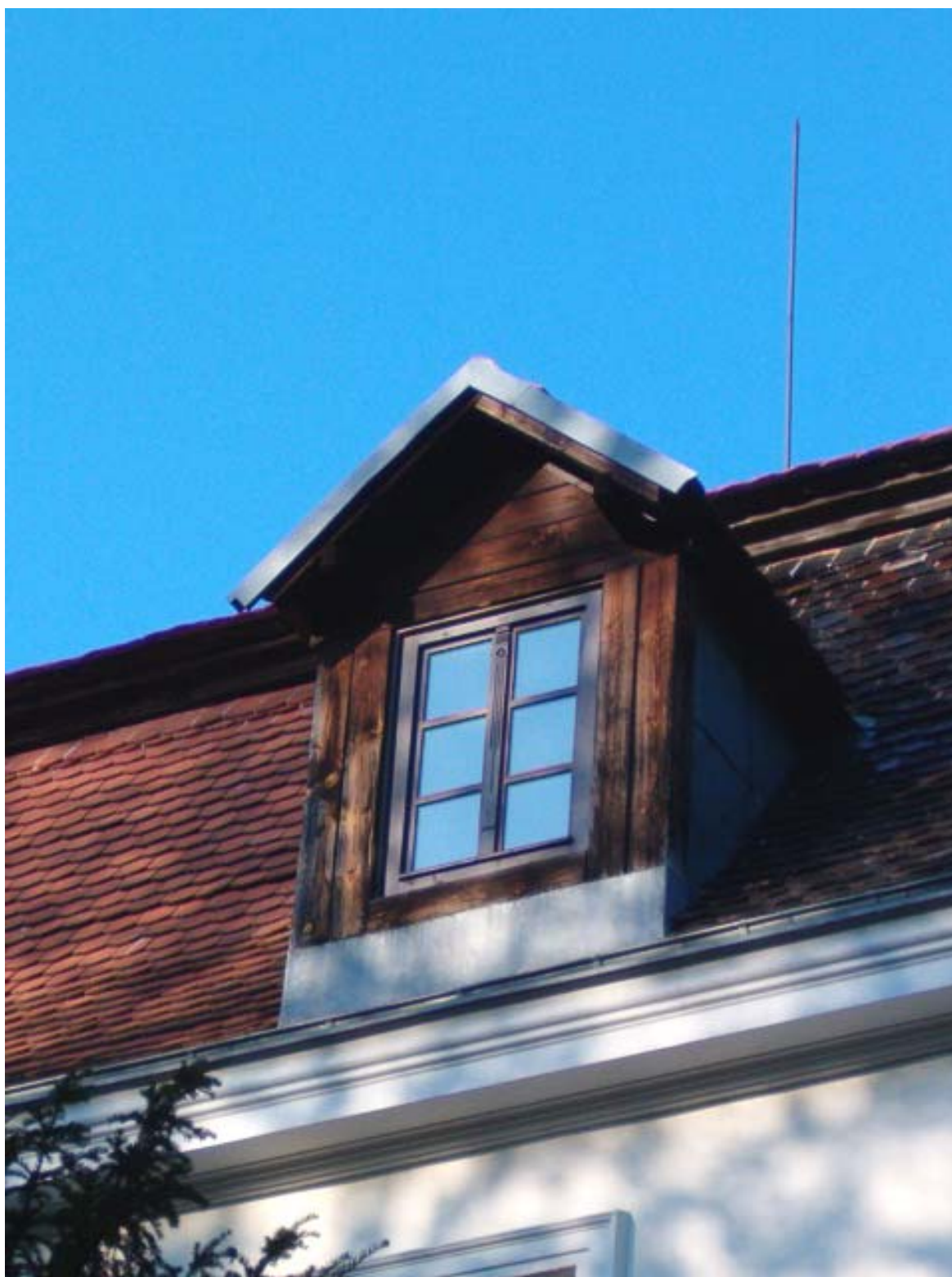
Fot. 140. Jedna z współczesnych lukarn elewacji południowo-zachodniej (ogrodowej).
