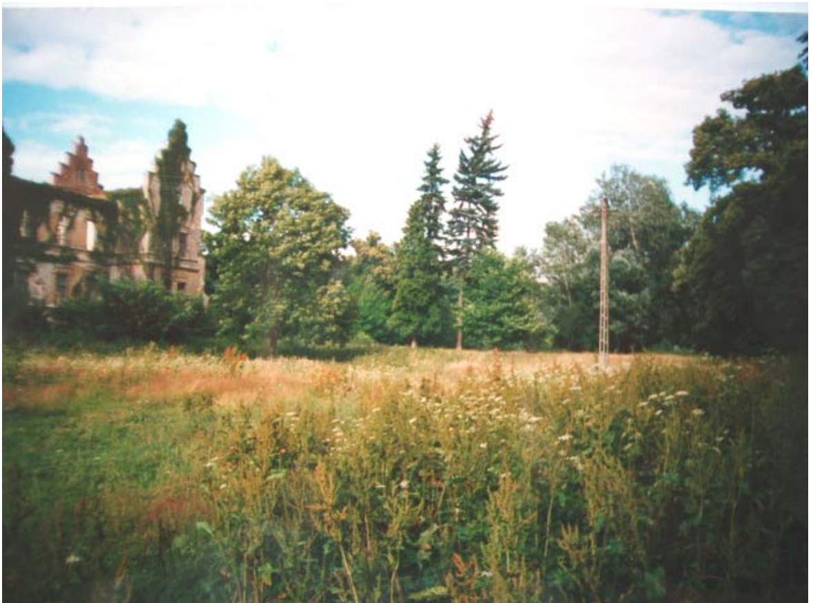
Fot. 6. Polana przy południowej elewacji pałacu.
