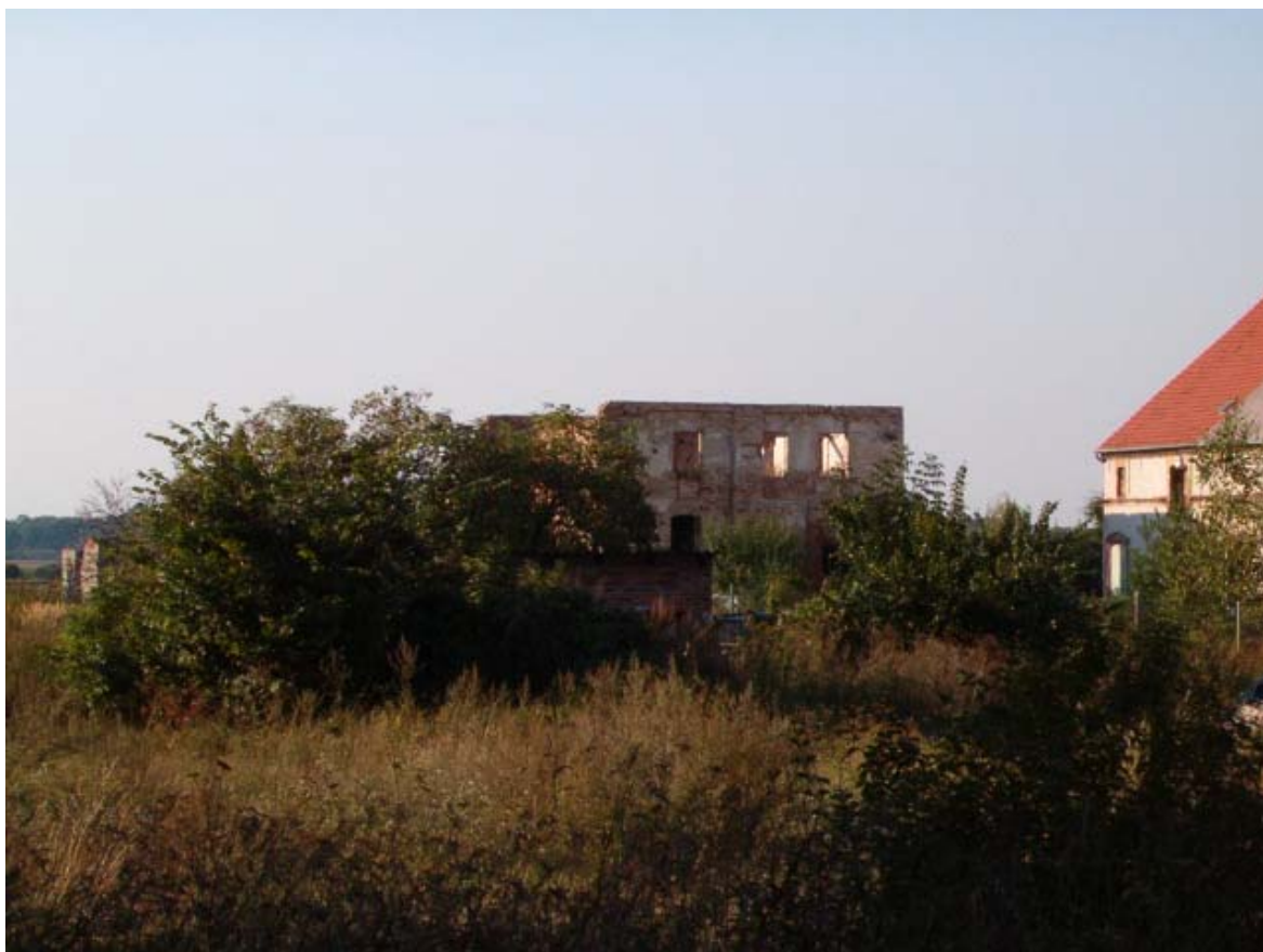
Fot. 145. Północno-zachodnia część dziedzińca folwarcznego.
