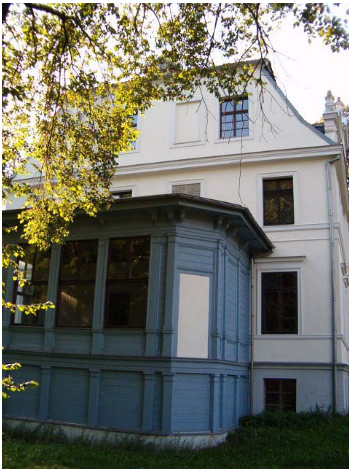
Fot. 144. Elewacja południowo-wschodnia pałacu.
