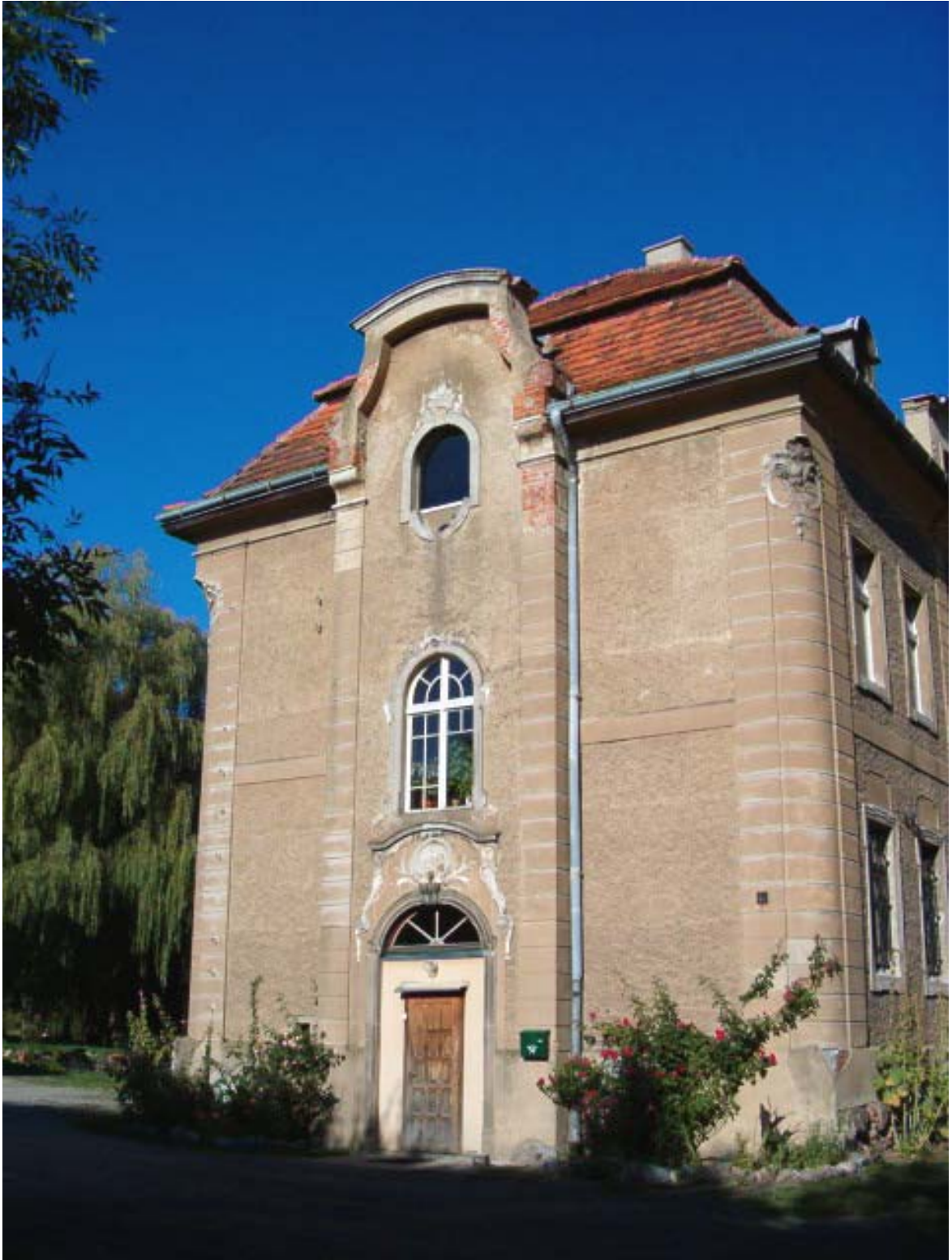
Fot. 44. Elewacja zachodnia skrzydła północnego.
