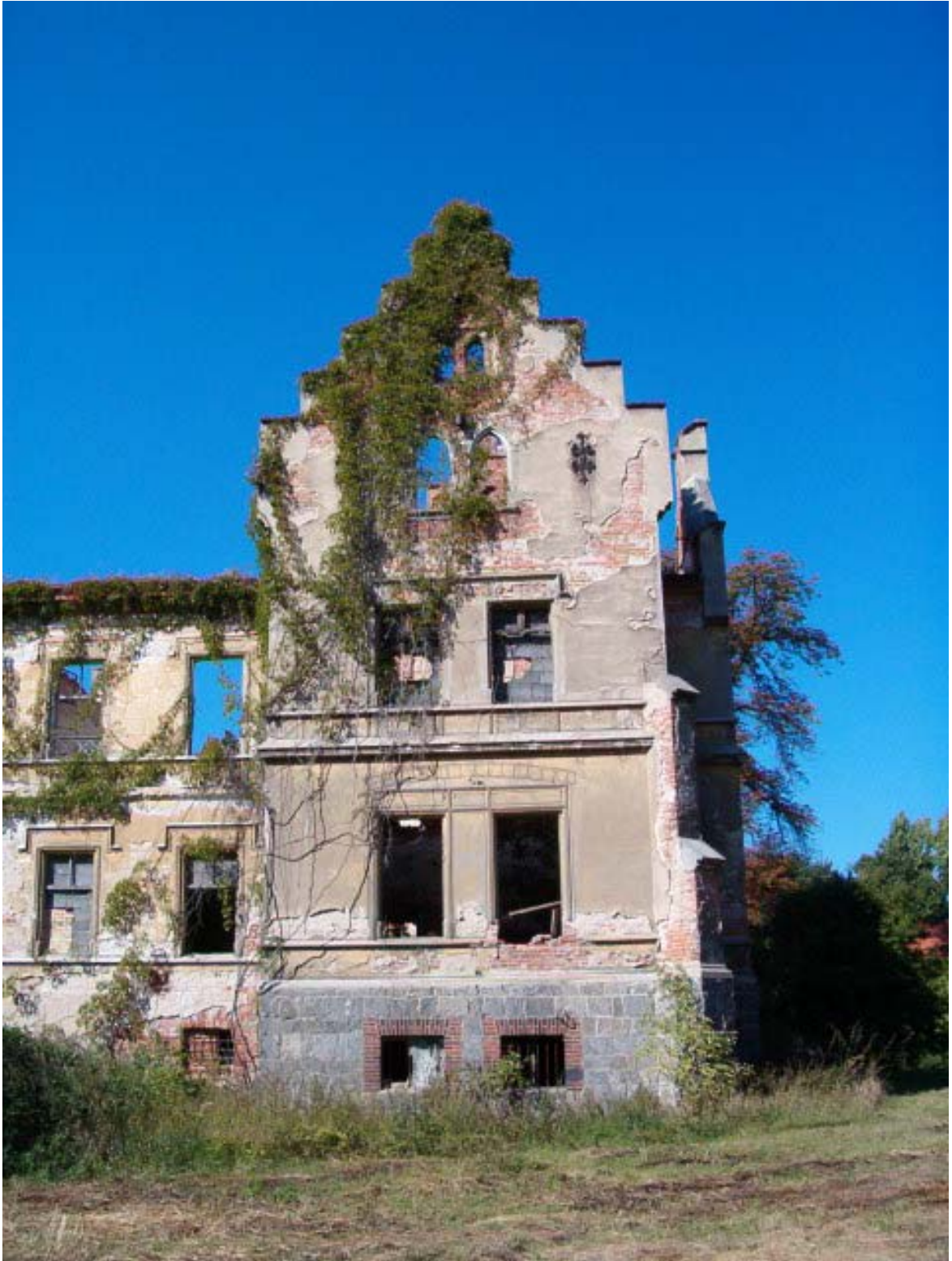
Fot. 20. Elewacja południowa południowo-wschodniej wieży.
