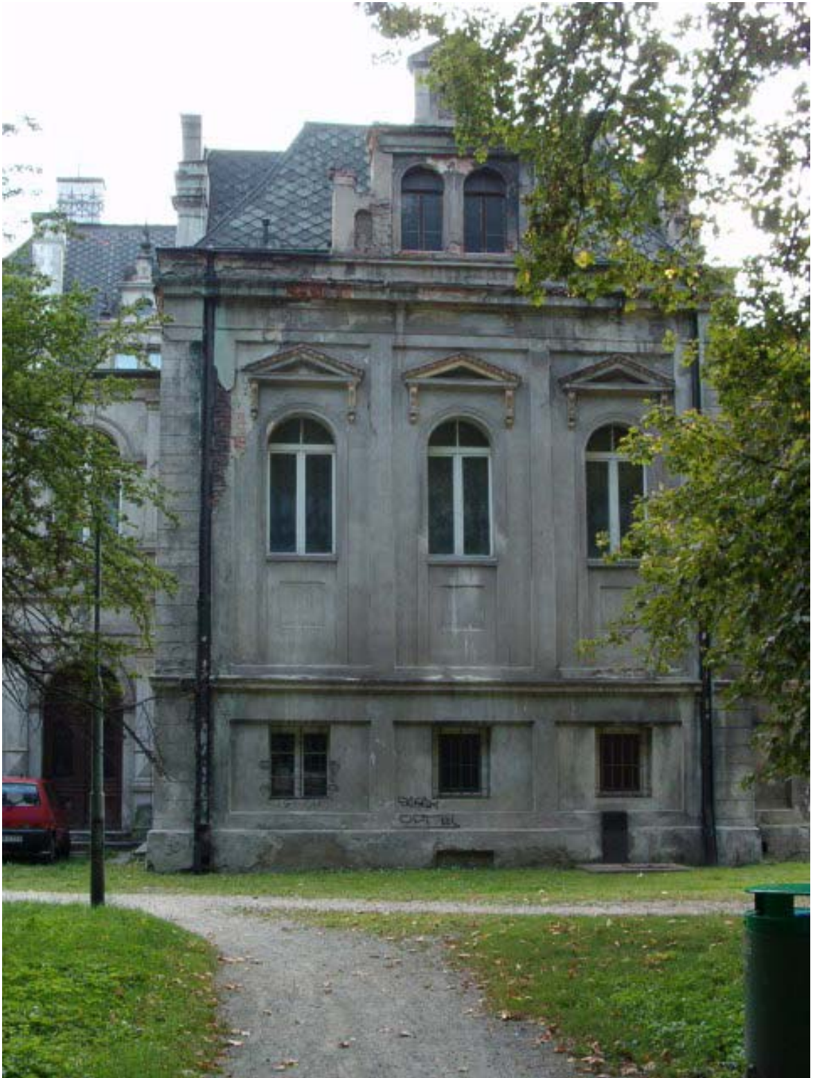
Fot. 117. Elewacja północna skrzydła północno-zachodniego.
