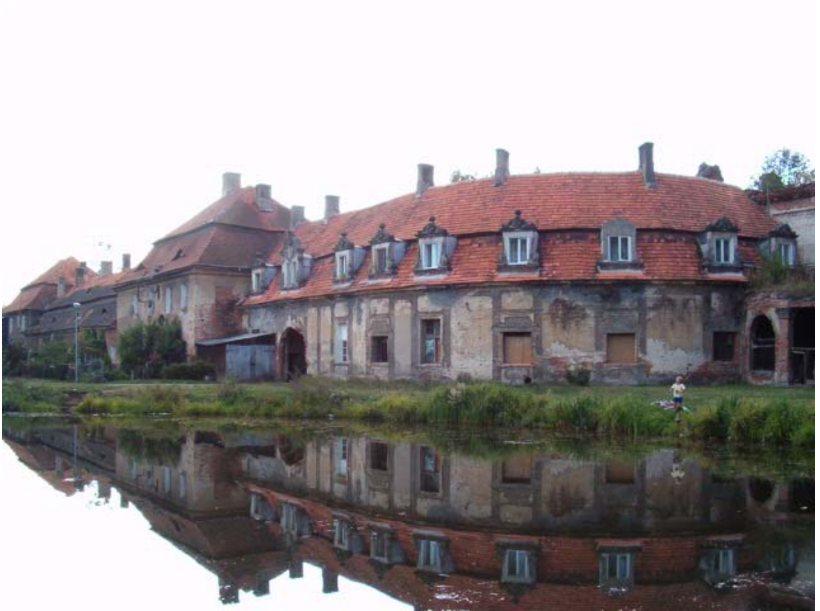
Fot. 86. Elewacja ogrodowa skrzydła południowego.
