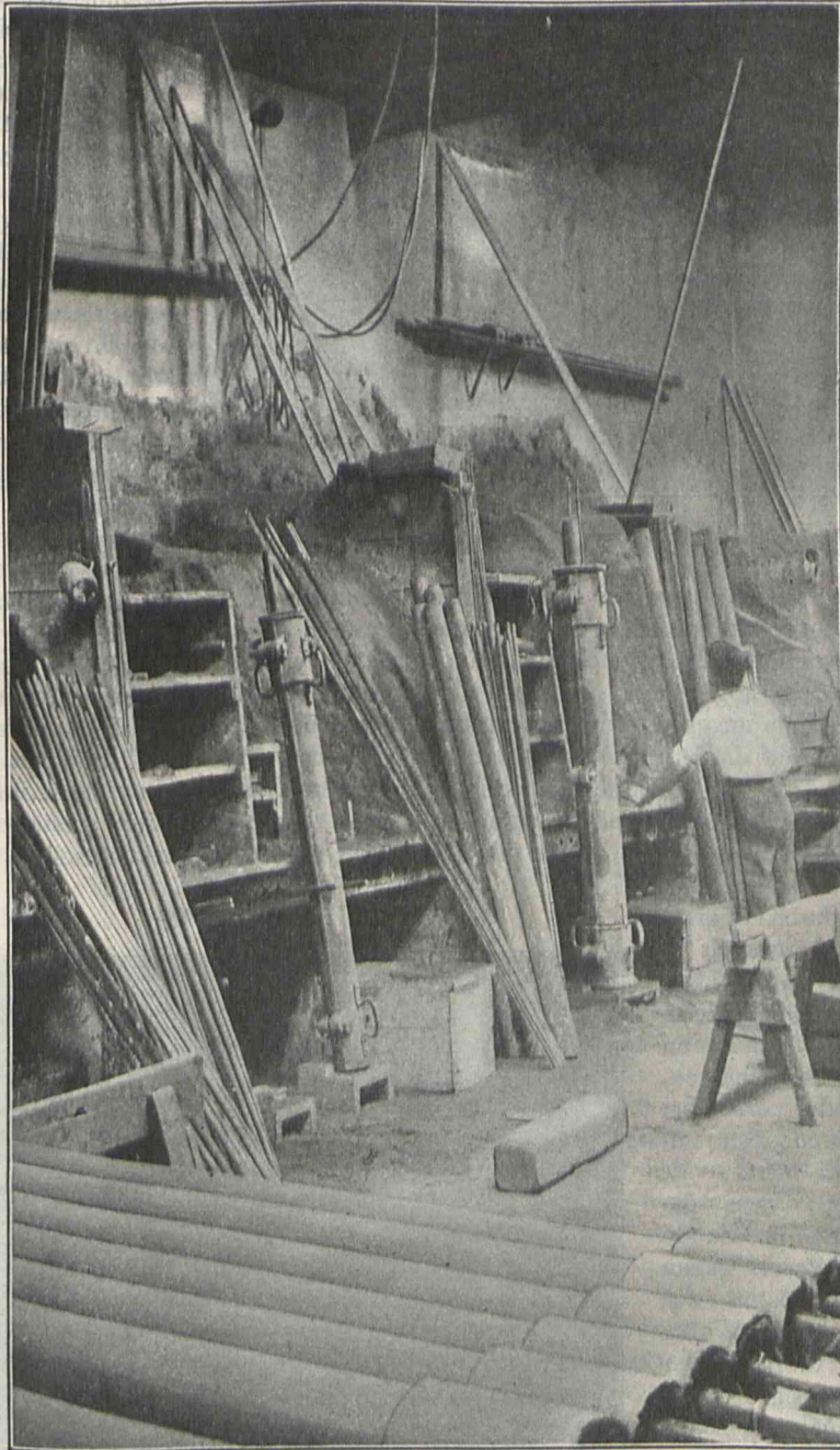
Die Fabrikation eiserner Röhren: Fertig gestampfte Kerne.
