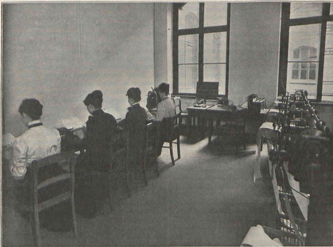
Ansicht einer vollständigen Rowland-Optoplex-Station.
