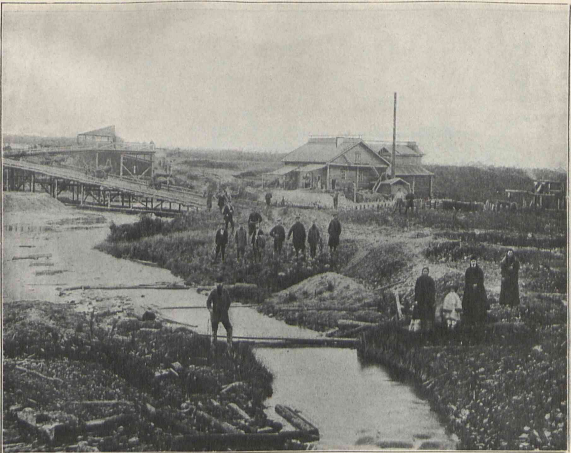
Ansicht einer Platinwäscherei nebst Pumpstation zum Ausheben des Wassers aus den Gruben.
