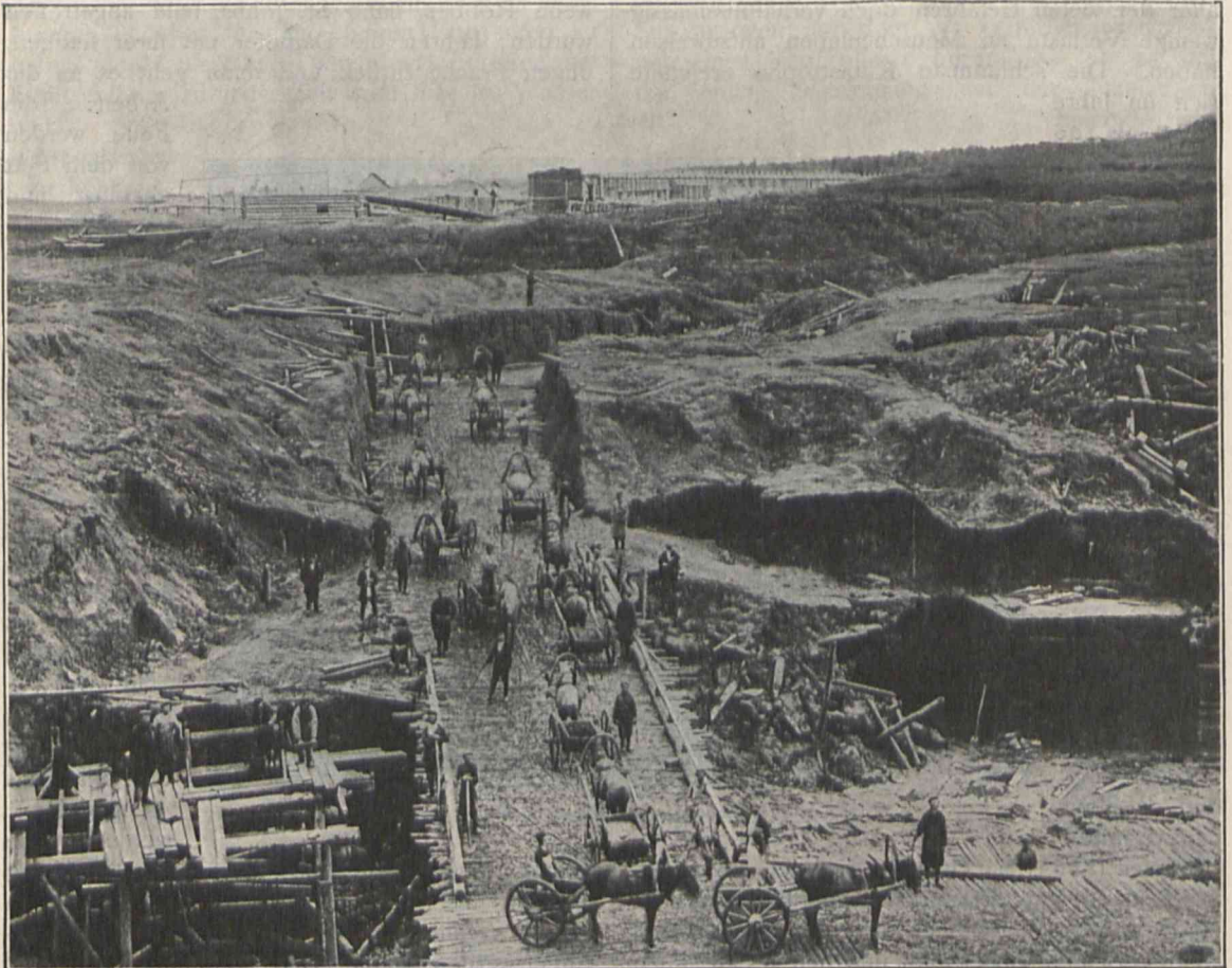
Abteufung und Beförderung des platinhaltigen Sandes nach der Wäscherei. (Durchschnittlicher Gehalt an Platinerz 5—10 g in 1000 kg.)
