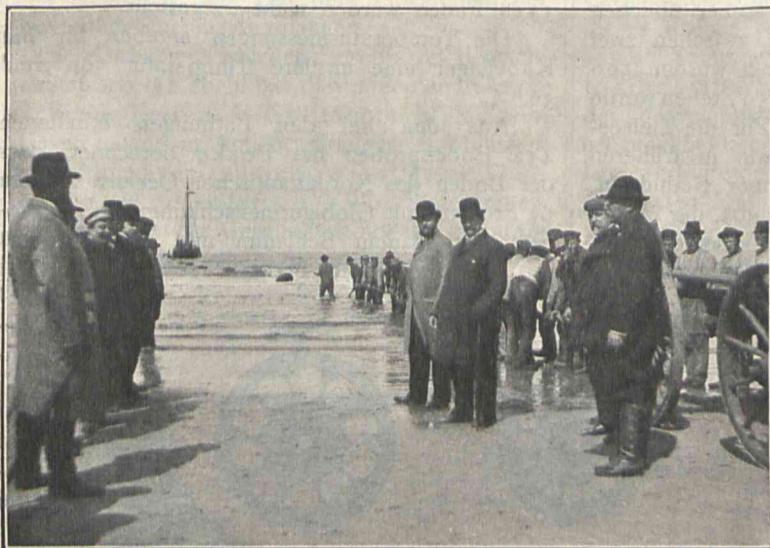
Die Landung des Küstenkabels.
