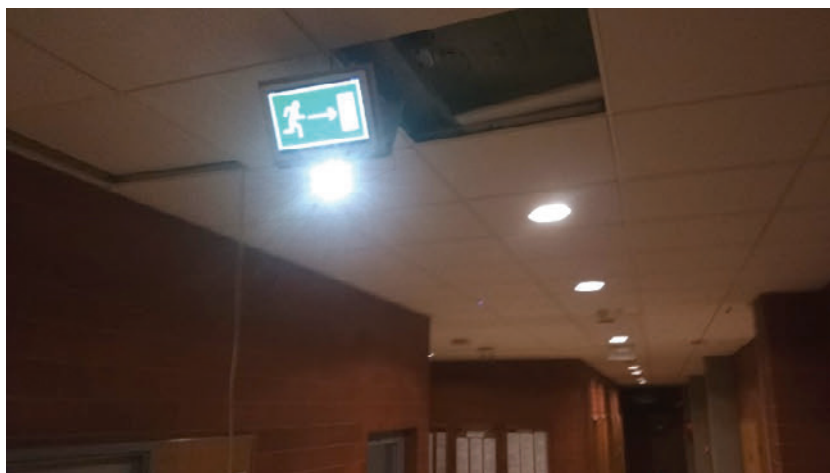
Rys. 34. Opracowana oprawa oświetlenia awaryjnego w rzeczywistych warunkach pracy
