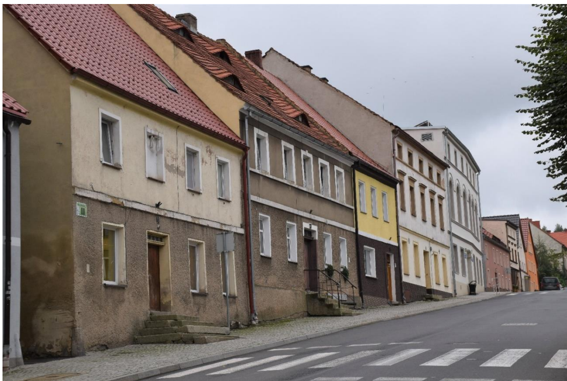
Ryc. 73 Dobromierz. Przedproża wyrównujące poziom wejść do domów mieszkańskich zlokalizowanych w pierzei południowej placu rynkowego (fot. autorka).
