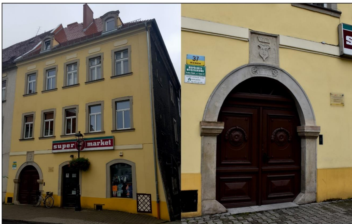
Ryc. 30 Kamienica nr 37 w Gryfowie. Portal wejściowy z datą 1603 r. (fot. autorka).
