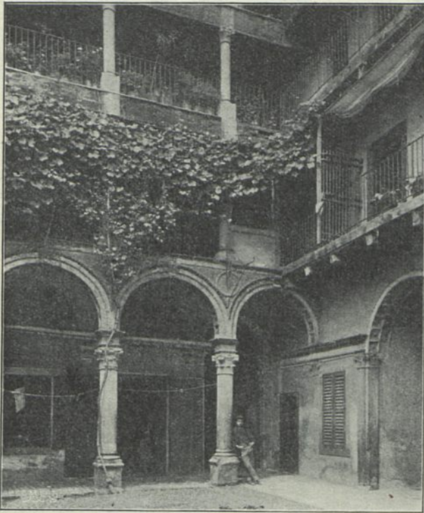
Hof des Hauses Nr. 104 an der Via Pignolo zu Bergamo.
