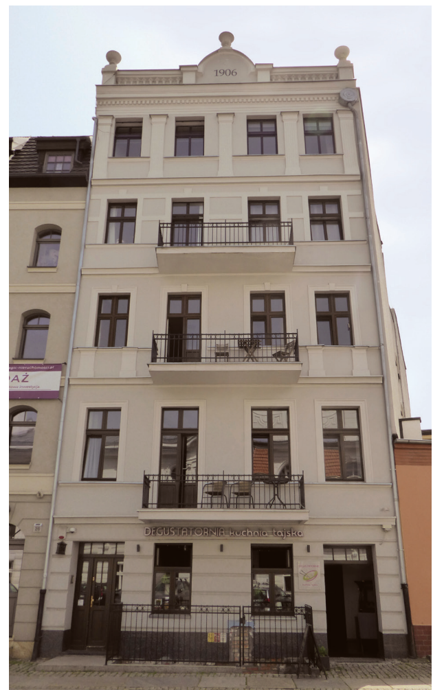
Fig. 1. Toruń, 24 Fosa Staromiejska Street – northern façade (photo by J. Kucharzewska, 2022)
