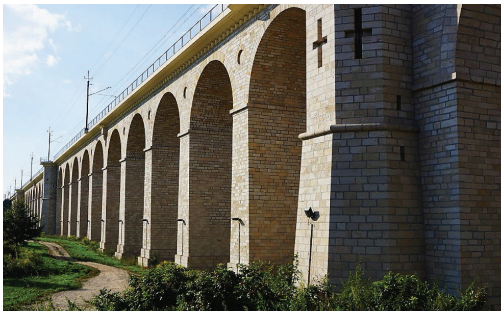
Fot. 15.1. Południowy widok mostu od strony starego miasta Photo 15.1. South view of the bridge from the old town
