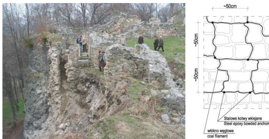
Rys. 8.1 Fragment murów obwodowych zamku „Lenno” (po lewej), cięgna stalowe i kotwy (po prawej), [255]
