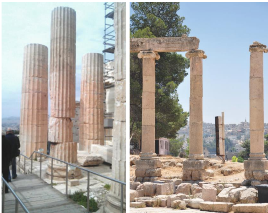
Rys. 5.81 Deformacje resztkowe kolumn powstałe w wyniku wstrząsów sejsmicznych.
