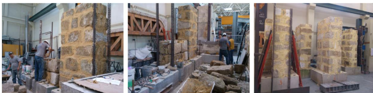
Rys. 2.12 Wznoszenie testowanych ścian oraz ich tekstura, [76]
