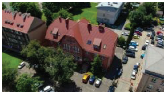
Fot. 5.4. Budynek Collegium Civitas
