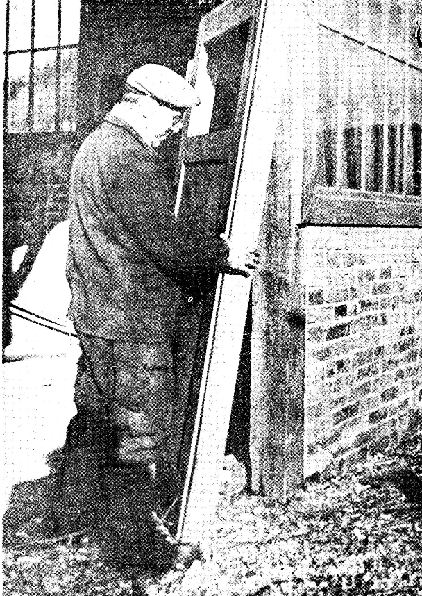
Warsztat stolarski Grupy budowlano-reмонтowej Ekspozytury CZ POM Lubin. A. Minkowicz w kontyjnje otwory okienne i drzwiowe dla wszystkich budów Grupy. Jan Walkowski, maister stolarski, sprawdza jakość drzew przeznaczonych na budowę w POM Międzyzlesiu.
