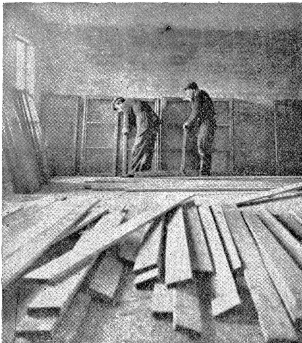
Rys. 3. Budowa baru dla traktorzystów w POM Ciechanki. W tej sali będzie świetlica. Ciesle Stefan Kordyga i Stanisław Najda przeglądają gotową stolarkę
