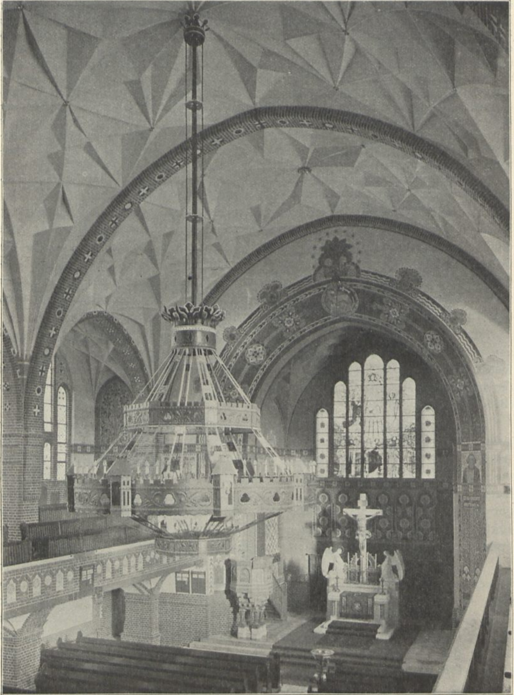
Eisenbetondecke der evangelischen Pfarrkirche zu Bromberg.
