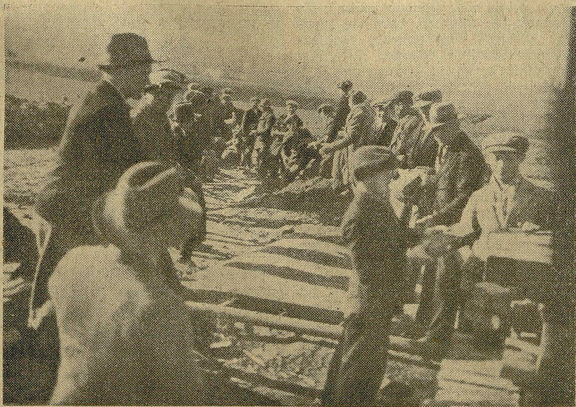
Budowa domu U. L. w Gaci 1935—36 r.
