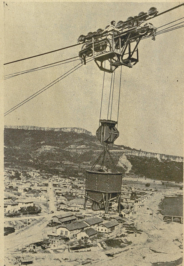
Budowa zapory wodnej
