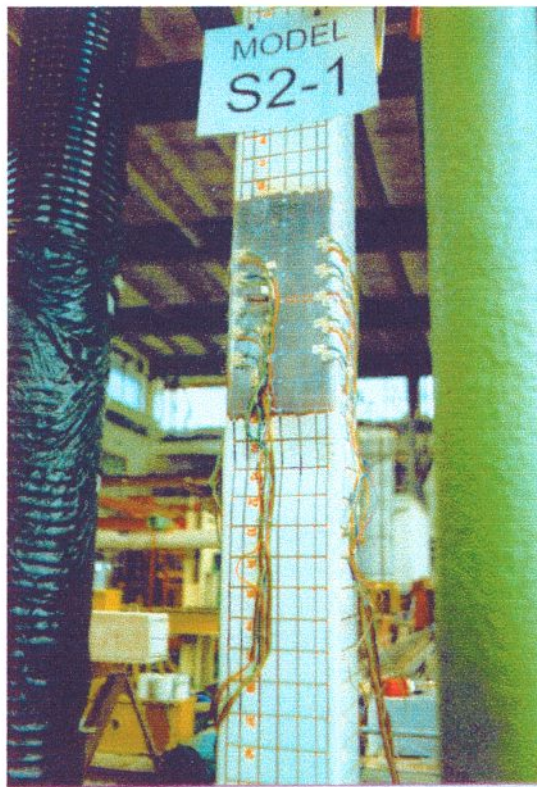
Rys. 4.37. Przykład zniszczenia słupa S2-1
