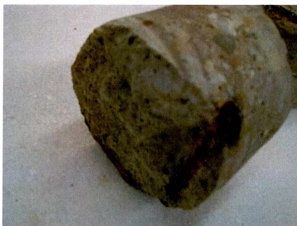
Rys. 3.20. Próbk rdzeniowa ze skorodowanym zbrojeniem i brakiem odwarstwionej otuliny
