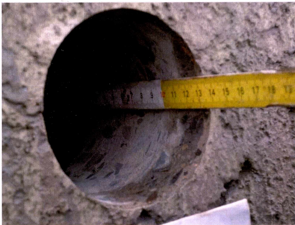
Rys. 2.7. Pomiar grubości powłoki chłodni
