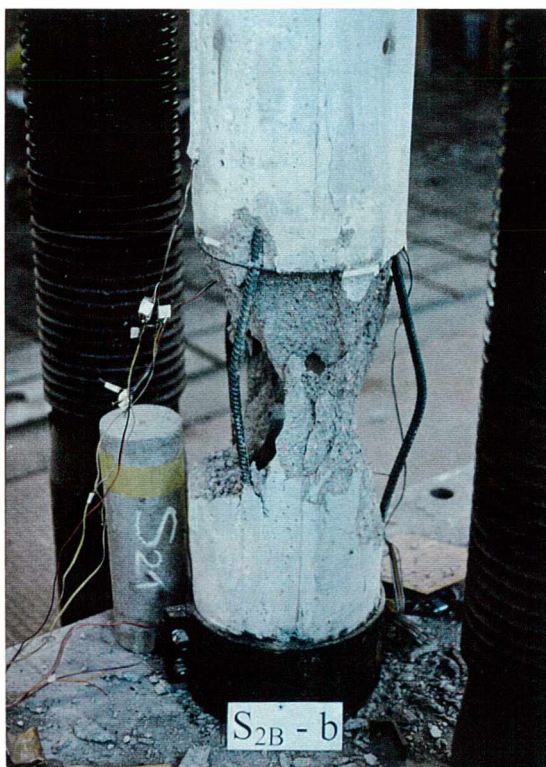
Rys.4.27. Zniszczenie elementu betonowego przez zgniecenie betonu (odpadnięcie fragmentu ścianki)
