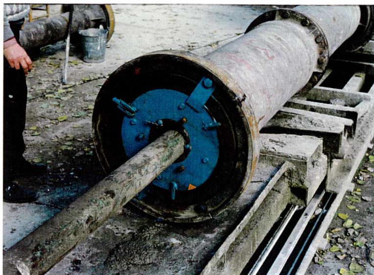
Rys.4.8. Podawanie betonu do wnętrza formy podstawowej
