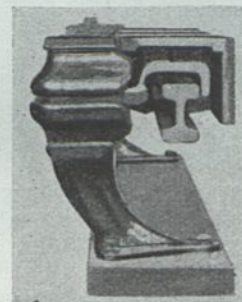
Abb. 110. Anordnung der Stromschiene für 1200 Volt Betriebsspannung.
