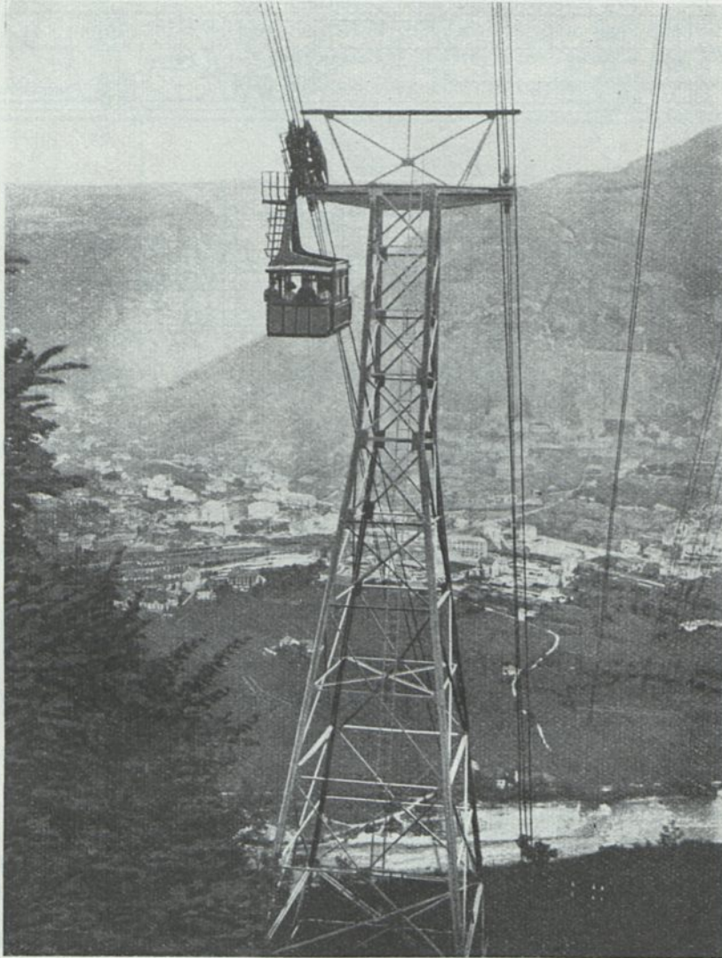
Abb. 597. Stütze mit Fahrzeug der Schwebeseilbahn Bozen—Kohlern (Bleichert).
