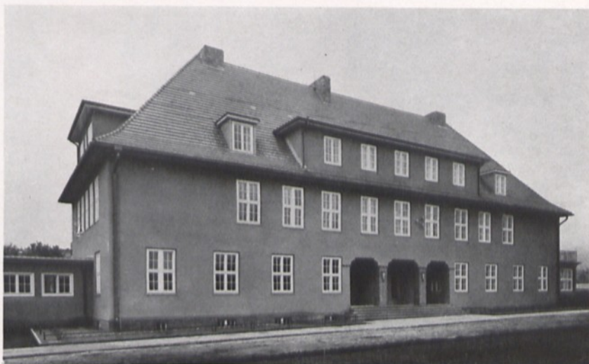
WOHLFAHRTSGEBÄUDE WEISSSTEIN ARCH. GEM.-BAUMSTR. LANGGUTH
