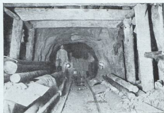
Abb. 24. (Austritt einer Kluftquelle am linken Stoss) Uebergang zur Sohlstollenerweiterung. Abb. 25.
