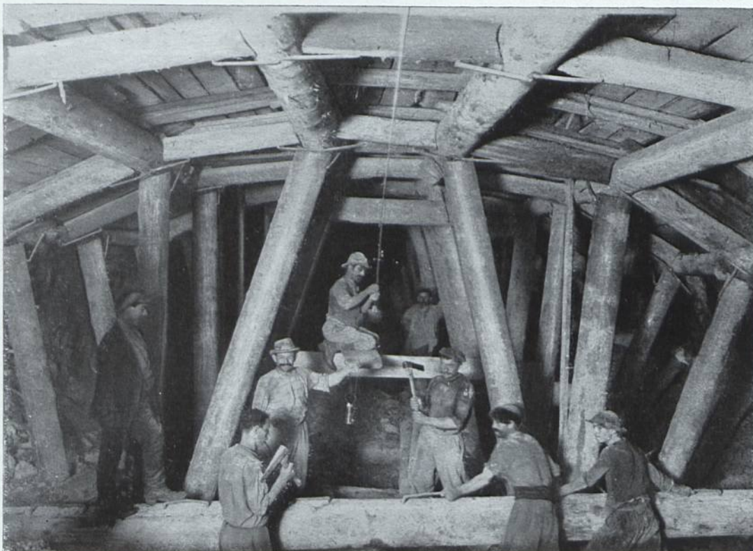
Abb. 28. Vollständiger Einbau der Calotte. — Der Vorarbeiter richtet die Axe aus.
