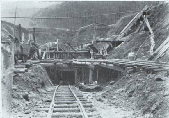
Abb. 43. Gewölbemauerung des Portals.
