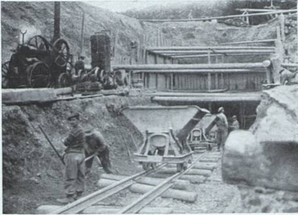
Abb. 41. Baubeginn des Nordportals.
