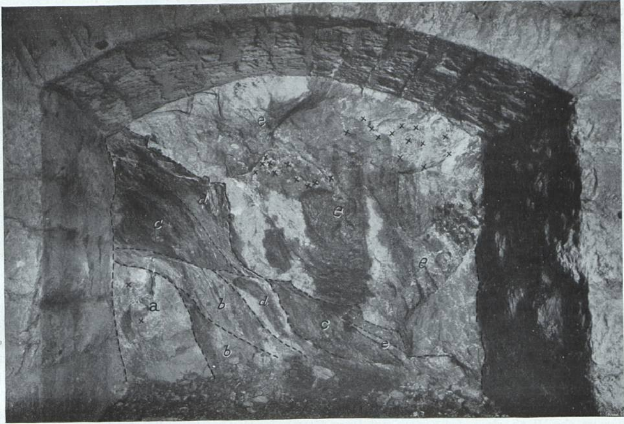
Abb. 1. Nische mit Ansicht der Ueberschiebung (Tunnelostseite bei 3320 m ab Südportal. Breite: 3 m; Höhe 2,5 m).
