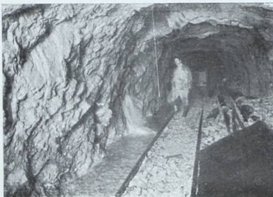
Abb. 24. (Austritt einer Kluftquelle am linken Stoss) Uebergang zur Sohlstollenerweiterung. Abb. 25.
