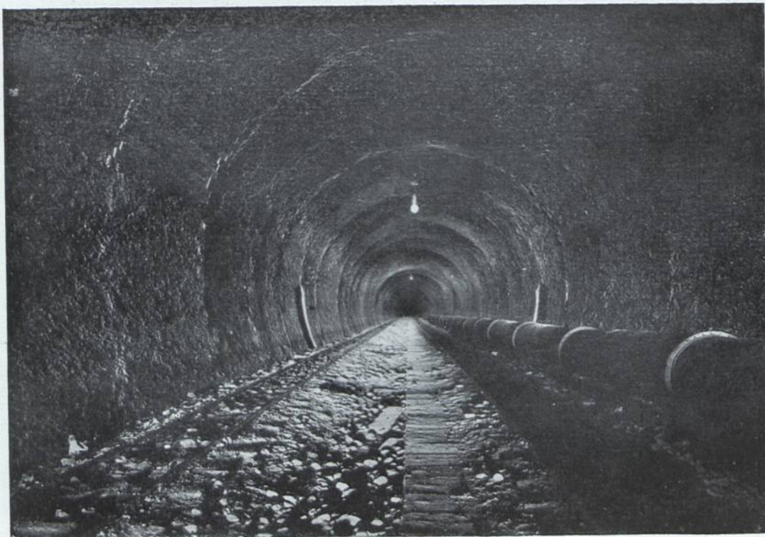
Abb. 34. Fertiger Tunnel in der Nähe des Südportals.
