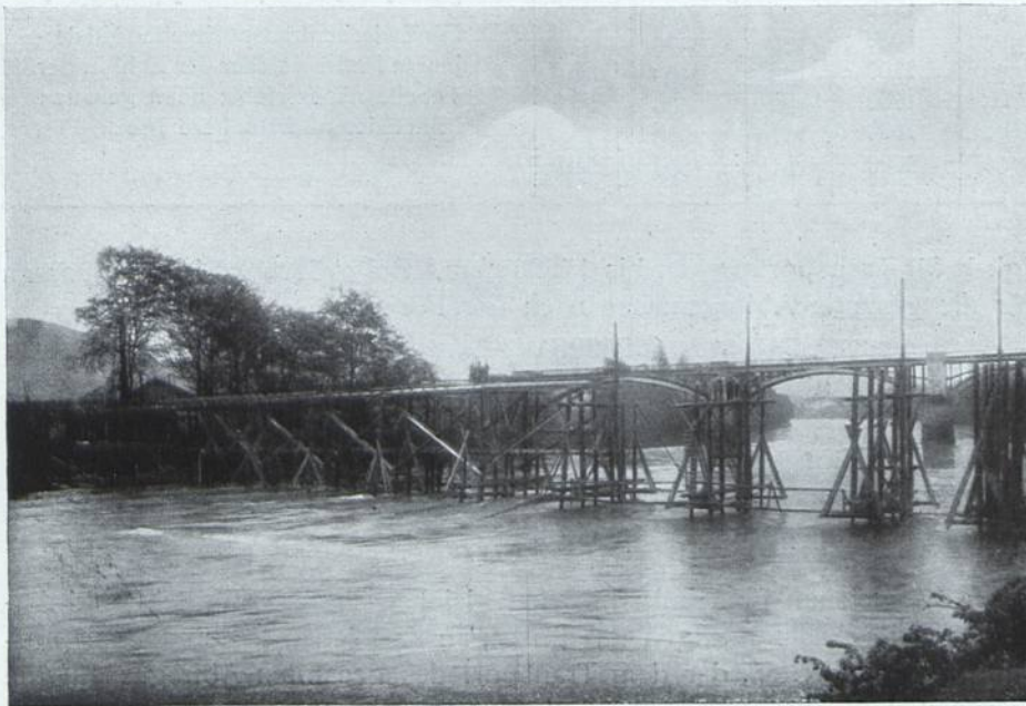
Abb. 4. Dienstbrücke über die Aare im Bau.
