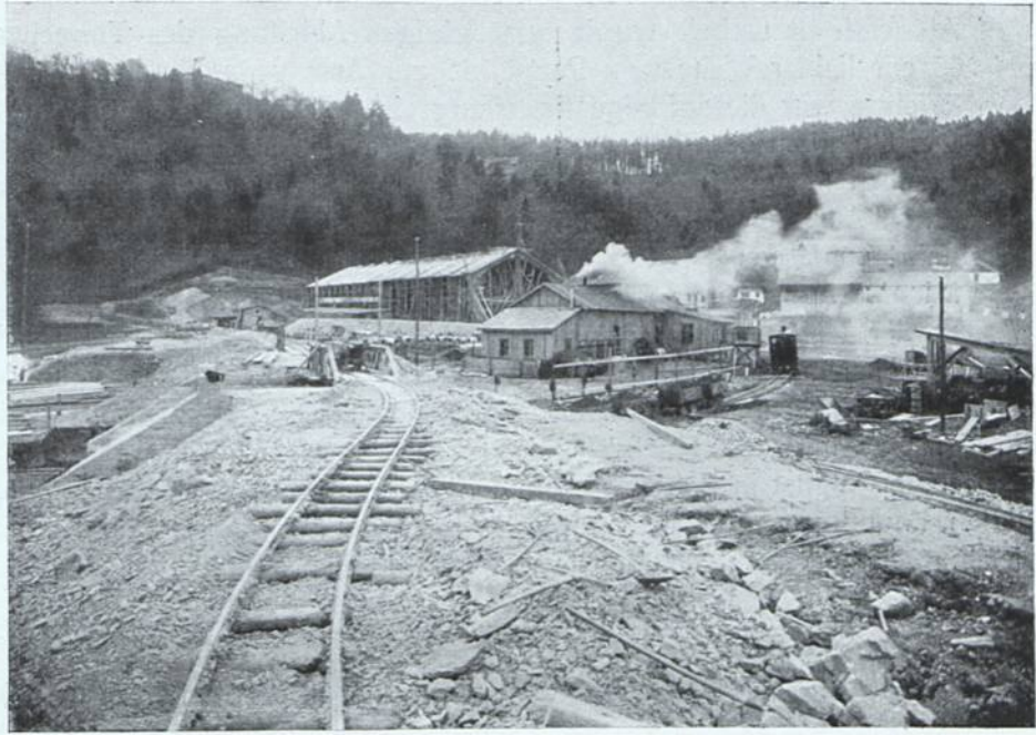
Abb. 5. Installation auf der Süd- seite im Entstehen.
