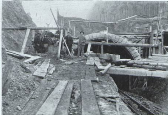
Abb. 44. Gewölbe ausgeschalt.
