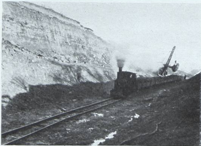
Abb. 67. Baggerarbeiten im Staffeleinschnitt bei Gelterkinden.
