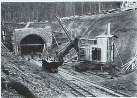
Abb. 45. Bagger verbreitert den Einschnitt am Nordportal.
