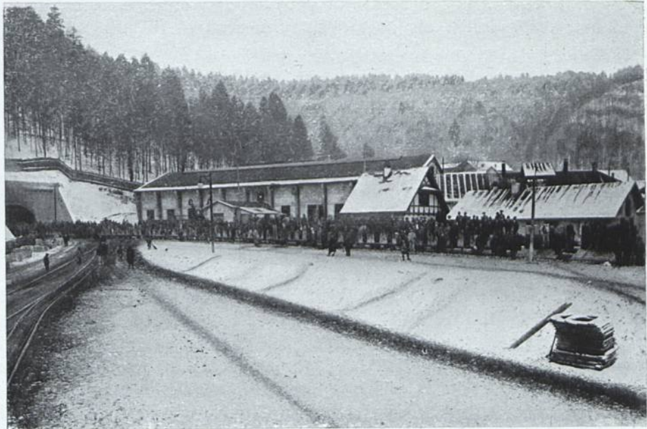
Abb. 29. Arbeiterzug vor dem Südportal.
