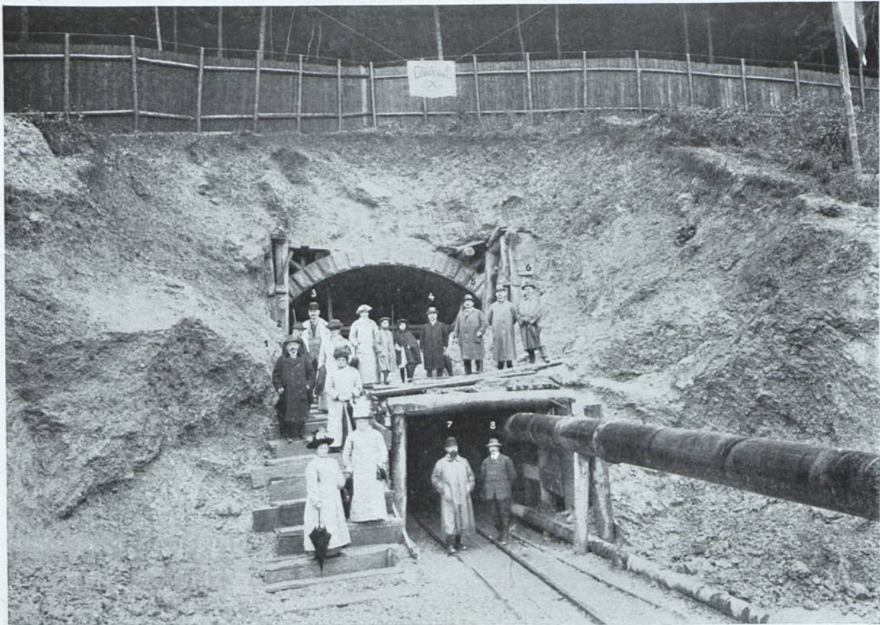
Abb. 36. Südportal, bergmännisch eingewölbt. (Besuch des Aufsichtsrates der Julius Berger A.-G. am 12. Aug. 1912). 1 Kommerzienrat Moser, Mitgl. des Aufsichtsrates. 2 Geh. Justizrat Dr. v. Krause, Mitgl. des Aufsichtsrates, Vizepräs. d. preuss. Abg.-Hauses. 3 Generalleutnant Exz. v. Rogowski, Mitgl. d. A.-R. 4 Geh. Kommerzienrat L. Aronsohn, Vors. d. A.-R., Mitgl. d. preuss. Abg.-Hauses. 5 Kommerzienrat J. Berger, Generaldirektor. 6 Regierungs- und Baurat a. D. R. v. Zabiensky, Direktor der Julius Berger Tiefbau A.-G. 7 Oberingenieur F. Kolberg, Direktor der Zweigniederlassung Olten. 8 Abteilungsingenieur Morf, Dipl. Ingenieur.
