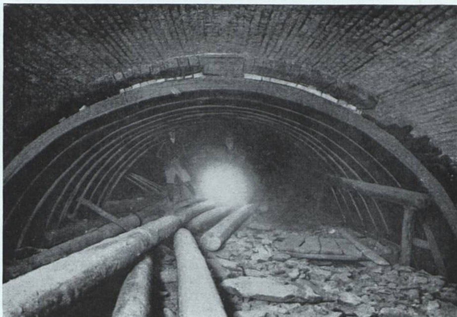
Abb. 32. Gewölbe vor der Ausschalung.
