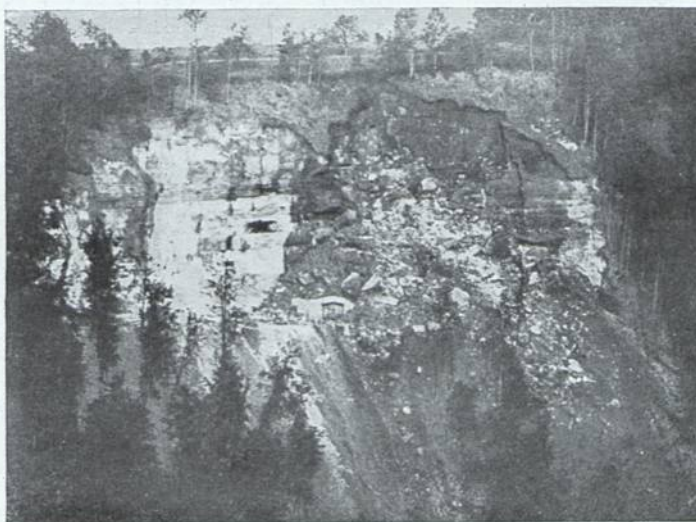
Abb. 51. Nach der Sprengung.
