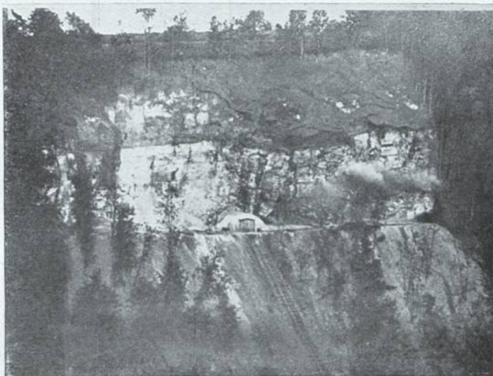
Abb. 50. Während der Sprengung.
