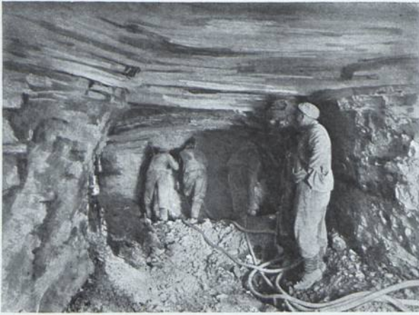
Abb. 22. Bohrung auf dem Schotterhaufen.
