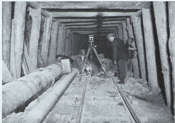
Abb. 54. Theodolit im Tunnel.
