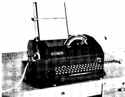
Perforator, na którym dziurkowana jest taśma. Z prawej strony aparatu widoczny jest licznik, na prawo przy rękopisie skala licznika.
