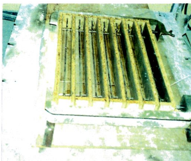
Rys. 4.2. Forma zespolona z ułożonym zbrojeniem przed zabetonowaniem elementu.
