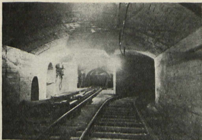
Rys. 1. Rampa pod ziemią na kopalni Wielki Jacek.
