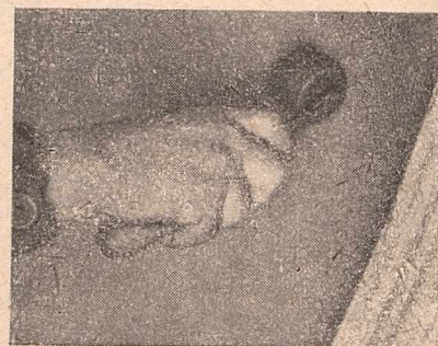
Rys. 2 — Usuwanie pęcherzy powietrza z gumowanej powierzchni (wałeczkowanie)
