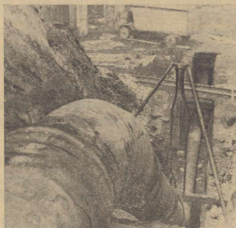
Spawka autogeniczna rurociągu \varnothing 500 mm przy połączeniu kulisto-kielichowym na terenie Śląska.
